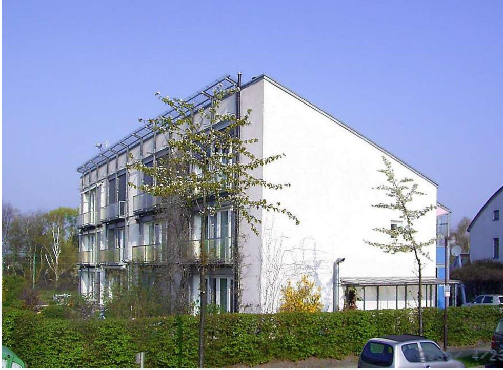
Görsel 4.8: İlk Pasif Ev binası, Mimarlar Bott, Ridder, Westermeyer Darmstadt-Kranichstein Almanya, (Passive House , 2021)
