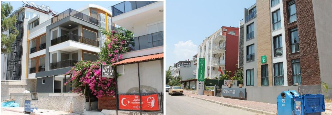
Şekil 45. Küçük otel işletmelerinden apart otellere dönüşümleri gerçekleşen tesisler (Kaynak: Orijinal)
