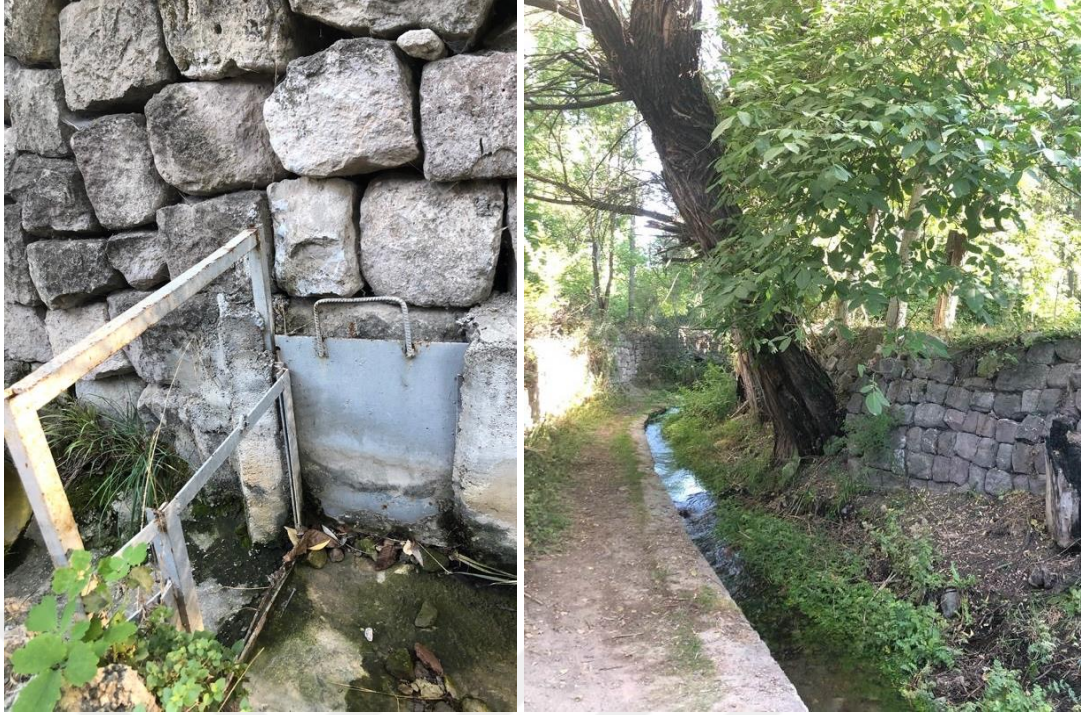
Şekil 4.78 : Sulama kanallarından bahçe girişlerine yönlendiren ayıraç (Darsiyak köyü / Gesi Vadisi, Kevseroğlu Ö. arşivi).
