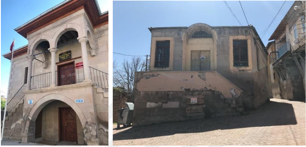
Şekil 4.68 : Vadilerdeki taş mektepler (Soldaki Üskübü köyü / Koramaz Vadisi, sağdaki Darsiyak köyü / Gesi Vadisi, Kevseroğlu Ö. arşivi).
