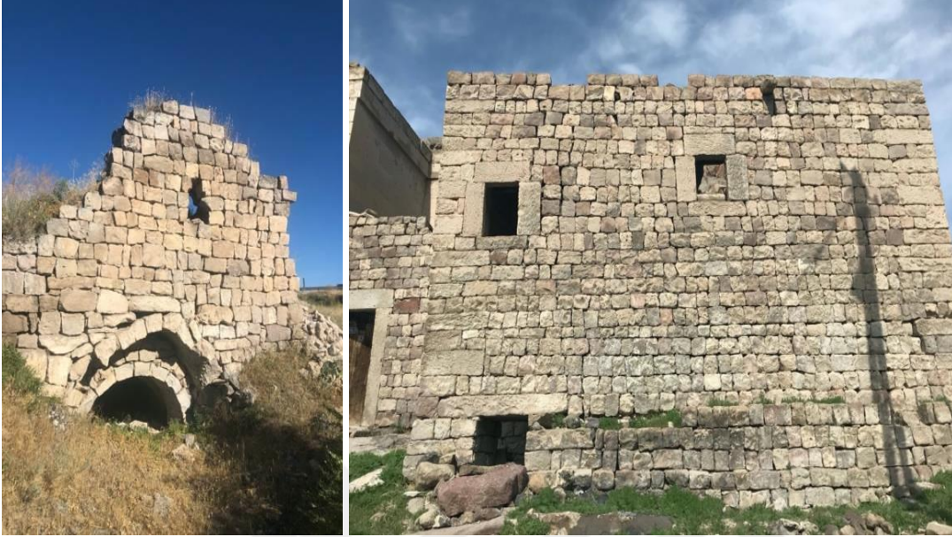
Şekil 4.45 : Değirmen Yapıları (Mancusun köyü / Gesi Vadisi, Kevseroğlu Ö. arşivi).
