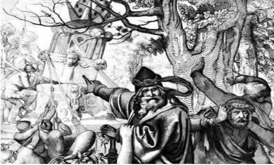
Resim 1: Charlemagne'ın Irminsul'u yıktırmasının tasviri. 1010
