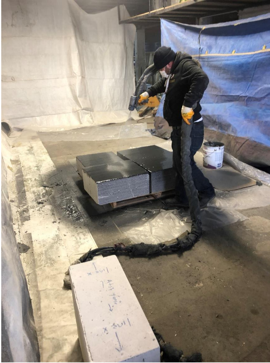
Resim 3.2. Gazbeton yüzeyinde uygulanan monolitik elastomer poliürea uygulaması
