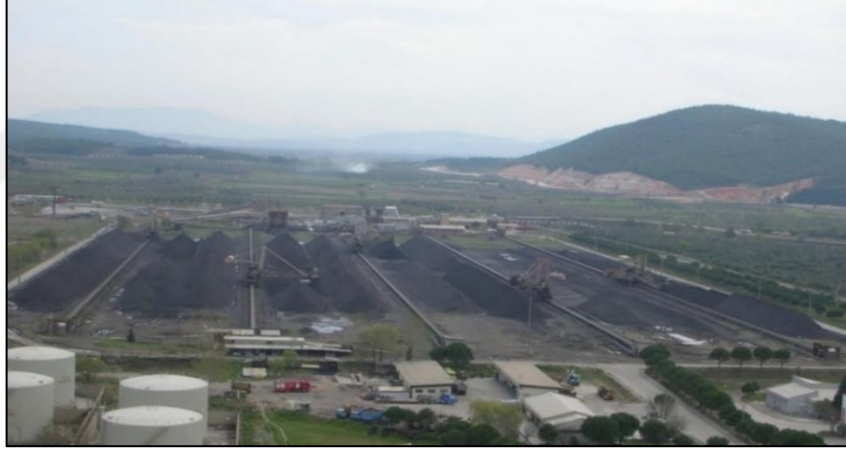
Şekil 1.12. Kömür stok sahası
