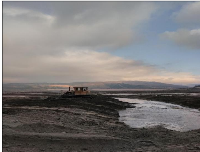
Şekil 1.24. Ayıtlı Kül Barajı
