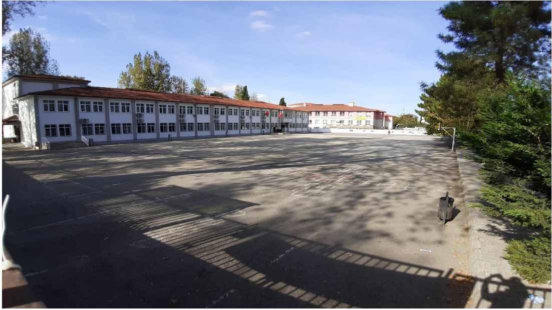
Şekil 3.211. Mithatpaşa mahallesi 26 numaralı acil durum toplanma alanı.
