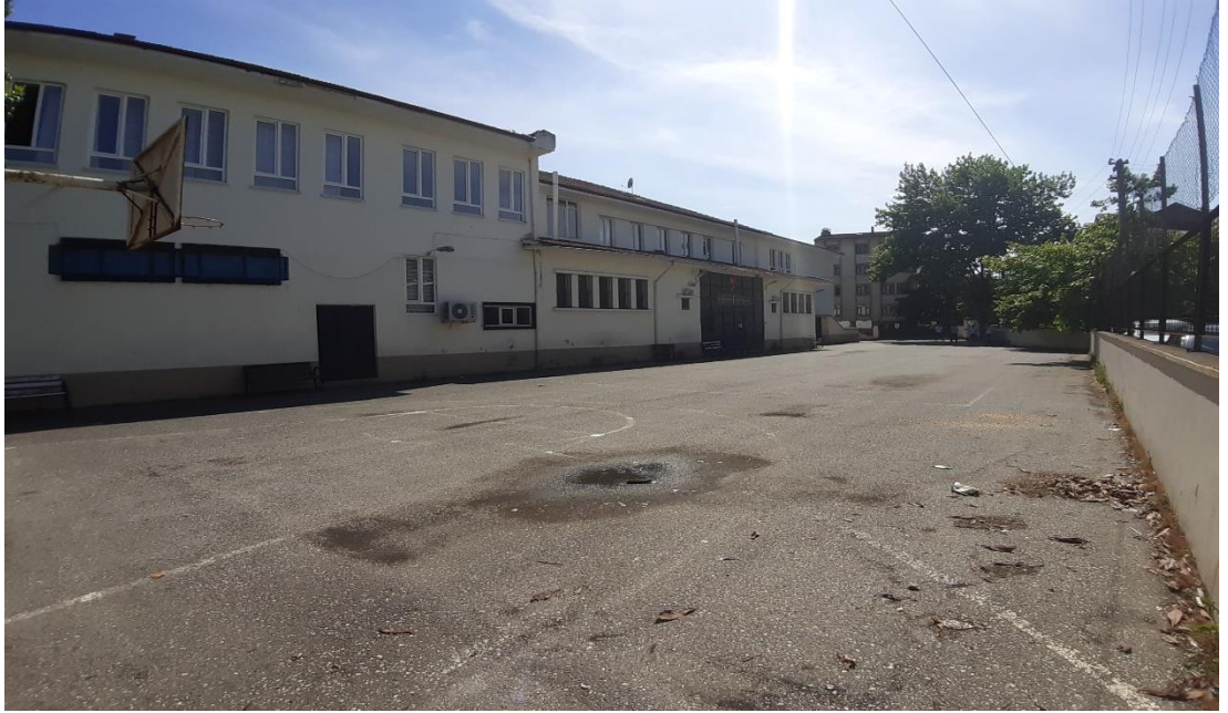
Şekil 3.97. Karaosman mahallesi 80 numaralı acil durum toplanma alanı.
