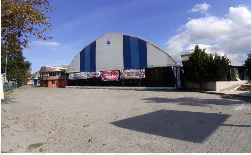
Şekil 3.205. Mithatpaşa mahallesi 22 numaralı acil durum toplanma alanı.
