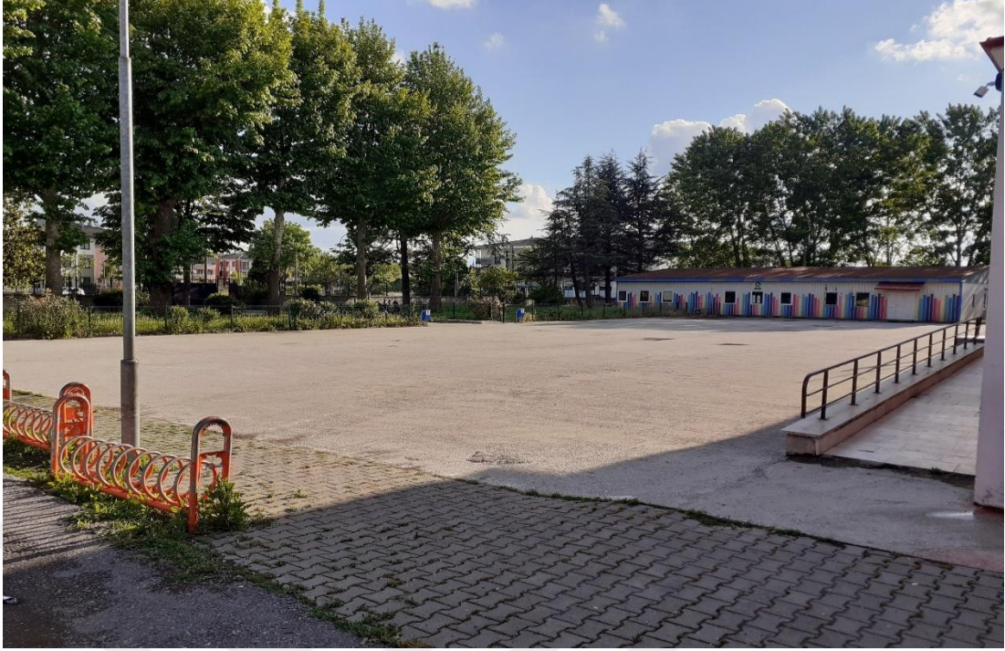
Şekil 3.32. Tekeler mahallesi 90 numaralı toplanma alanı.
