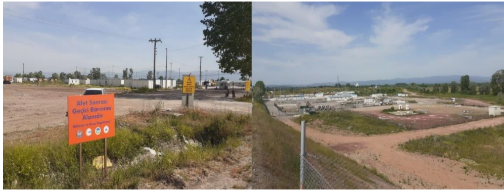
Şekil 3.255. Adapazarı parsel 383 geçici barınma alanı.
