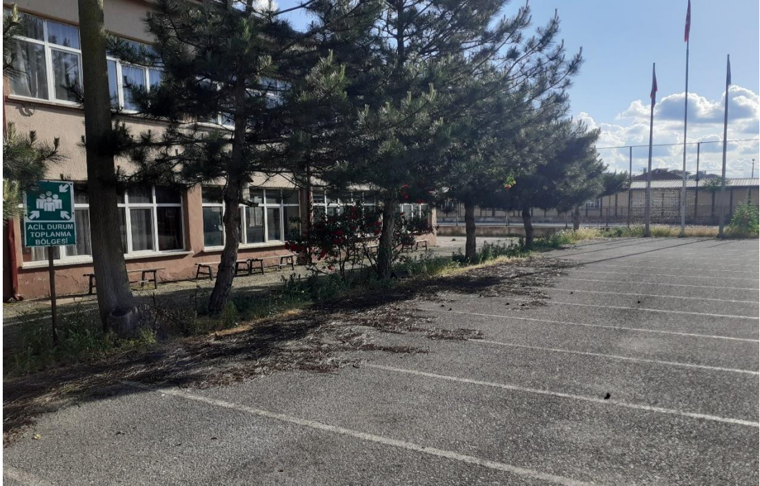
Şekil 3.29. Tekeler mahallesi 89 numaralı toplanma alanı.
