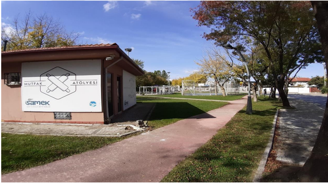
Şekil 3.225. Mithatpaşa mahallesi 33 numaralı acil durum toplanma alanı.
