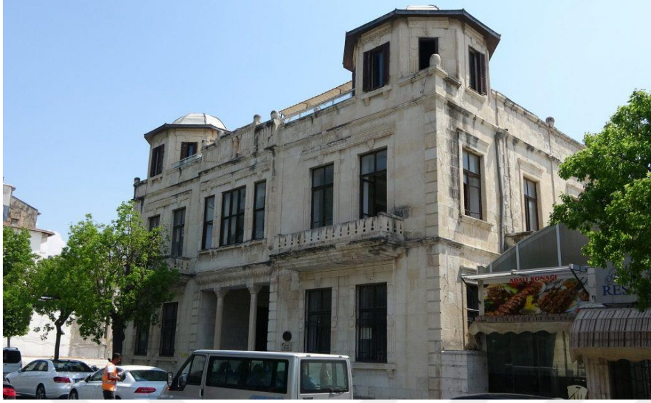
Resim 3.9. Adalı Konağı, (Yazar tarafından çekilmiştir, 2020)
