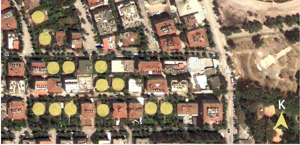
Şekil 4.6. 2010 yılına ait uydu görüntüsünde Akevler Mahallesi'nde var olan Ak-İş Konutları (Google Earth 2010 yılına ait uydu görüntüsü üzerinden, yazar tarafından işlenmiştir.)
