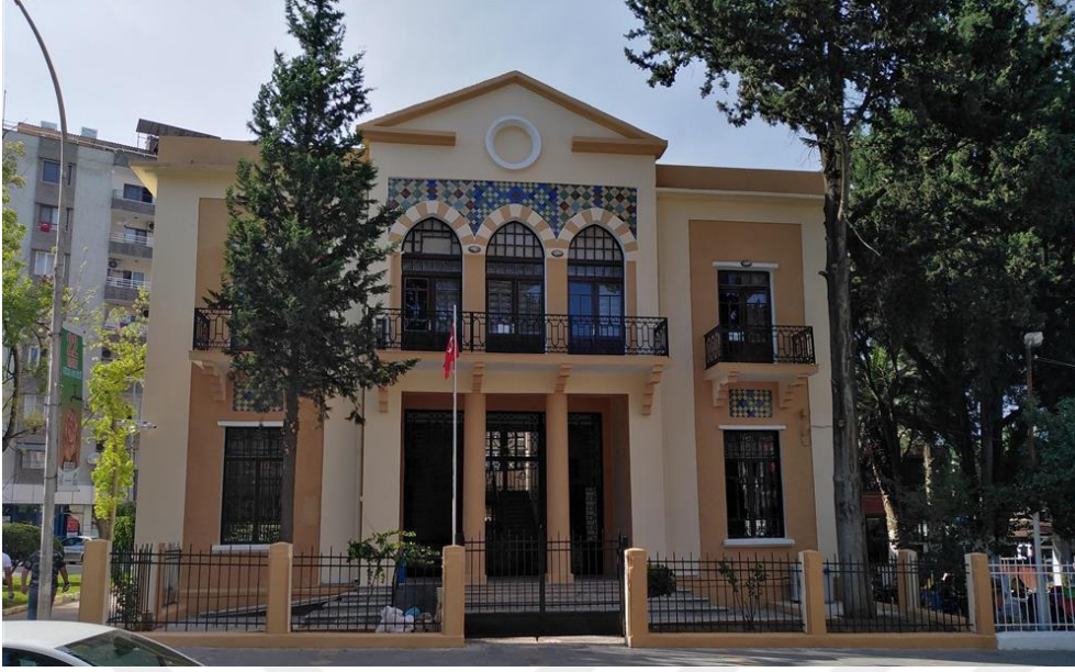
Resim 3.6. Kırıkhan eski Kaymakamlık Binası ( http://kirikhan.kutuphane.gov.tr )
