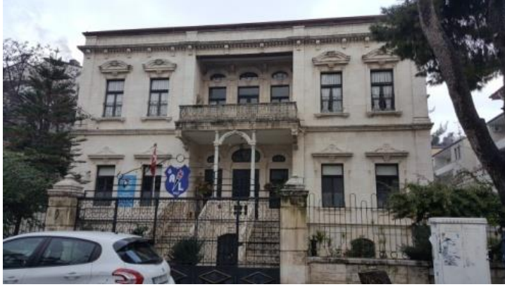
Resim 3.2. Rıfat Bereket Konağı (Yazar tarafından çekilmiştir, 2020)
