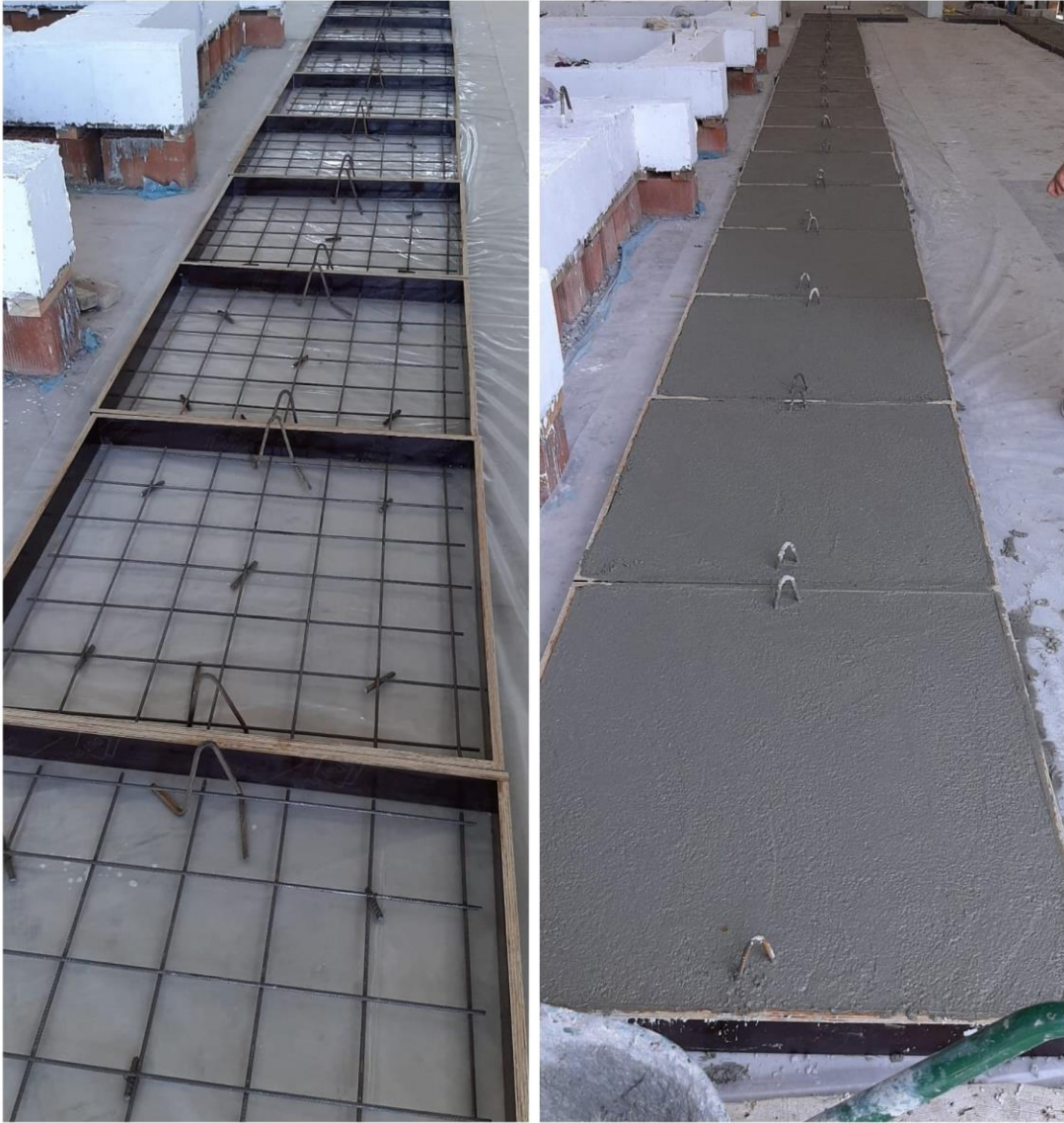
Şekil 3.22. Betonarme elemanların hazır hale gelmesi
