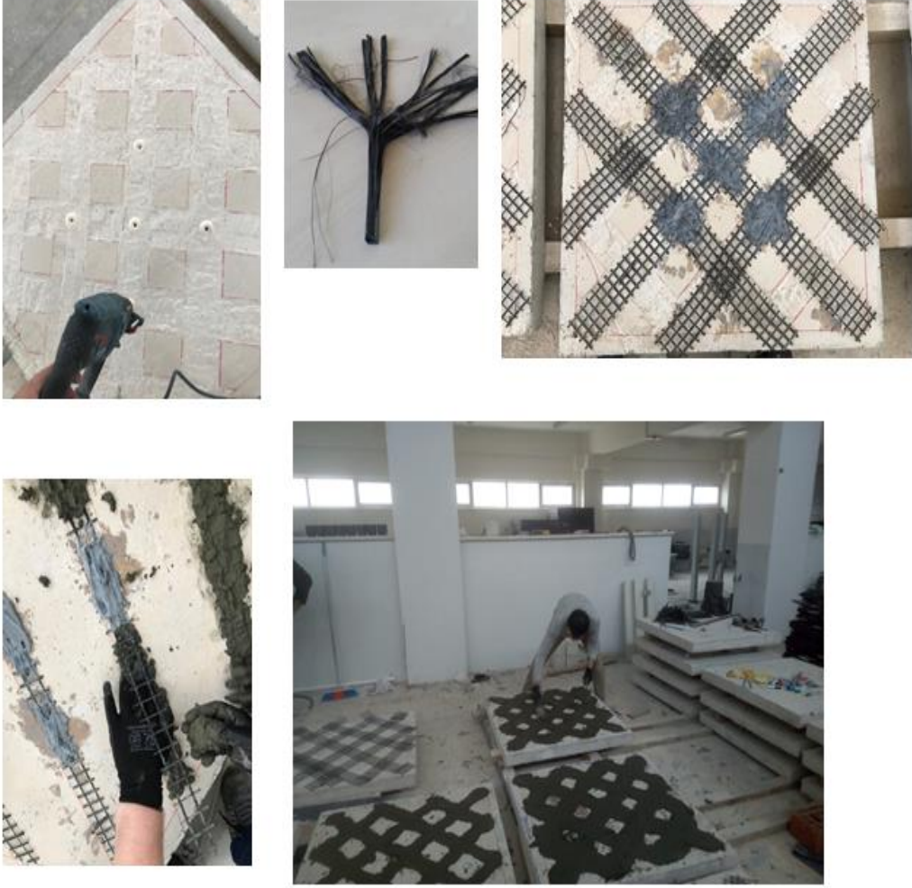
Şekil 3.27. Ankrajlı TRM şeritlerin döşemelere yapıştırılması
