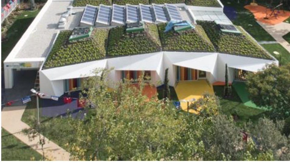
Şekil 80. Yağmur Sularını Arındırmak İçin Kullanılan Yeşil Çatı Uygulaması
