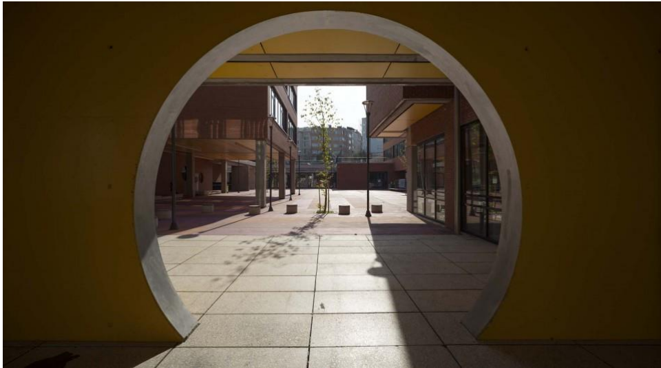
Şekil 65. Silivri Ortaokulu Yapısında Bulunan Devasa Geometrik Boşluklar
