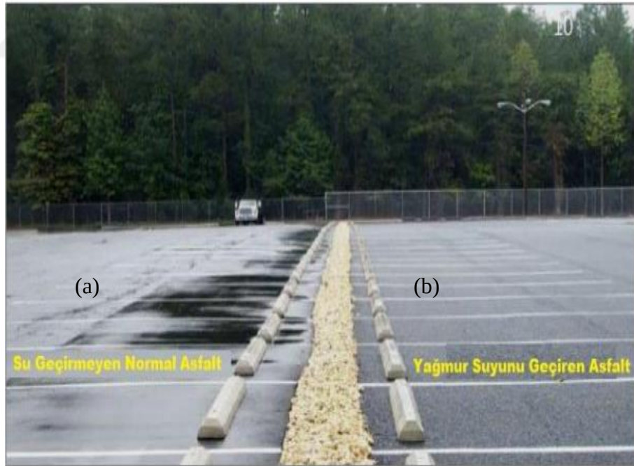
Şekil 6. (a) Geçirimsiz asfalt ile (b) geçirimli asfalt arasındaki fark ( Öztürk 2007)
