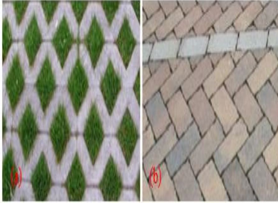
Şekil 7. Geçirimli kaplama türlerinden (a) ızgara tipi beton parke taşları ve (b) geçirimli beton kilit taşları (Öztürk 2007)
