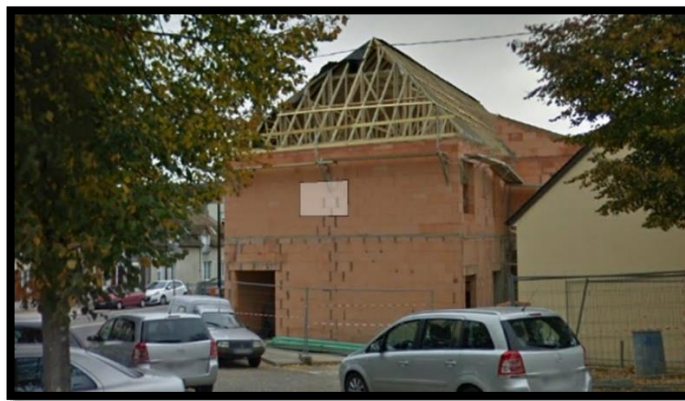
Fotoğraf 36 Ditib Alencon Camii rekonstrüksiyon projesi çatı yapım aşaması (Tarık GÜNER-Arşiv-Ekim 2018-Alencon-FRANSA)
