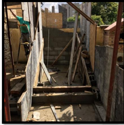
Fotoğraf 35 Caminin üst katında bulunan acil çıkış merdivenin yapım aşaması (Ditib Alencon Camii Rekonstrüksiyon Projesi) (Tarık GÜNER-Arşiv-Ekim 2018-Alencon-FRANSA)
