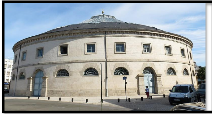
Fotoğraf 5 Buğday Hali (The Halle aux Blés) (Yusuf KORKMAZ-Arşiv-Aralık 2019- Alençon- FRANSA)
