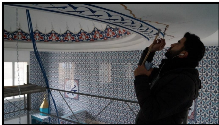
Fotoğraf 88 Kubbenin alt kasnağında ki desenlere tahrir çekilmesi (Yusuf KORKMAZ-Arşiv-Aralık 2019-Alencon- FRANSA)
