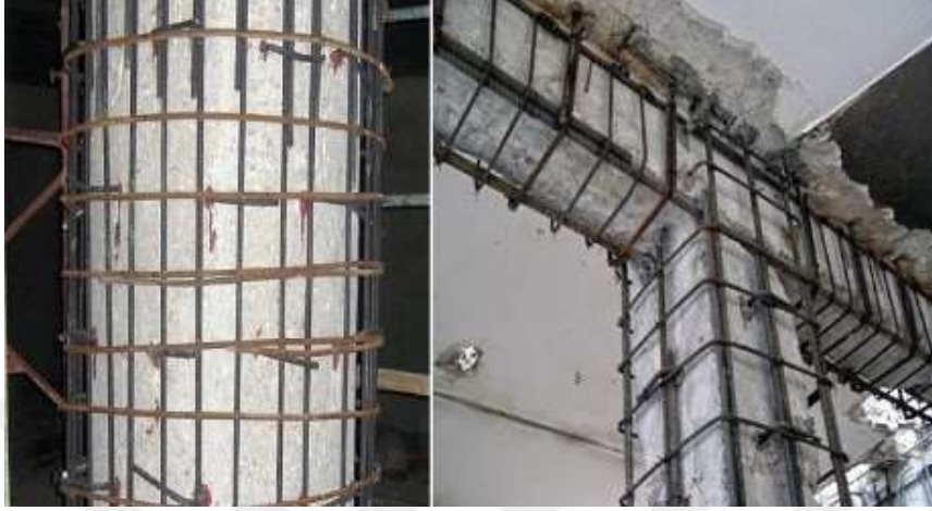
Şekil 2.1. Betonarme manto ile güçlendirme örneği (Ngmuhendislik, 2022)
