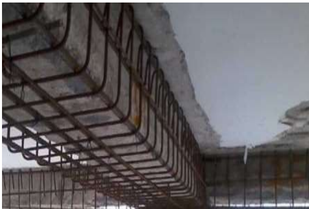
Şekil 2.3. Kirişlerin mantolama yolu ile güçlendirilmesi (Kocaboğa, 2019)
