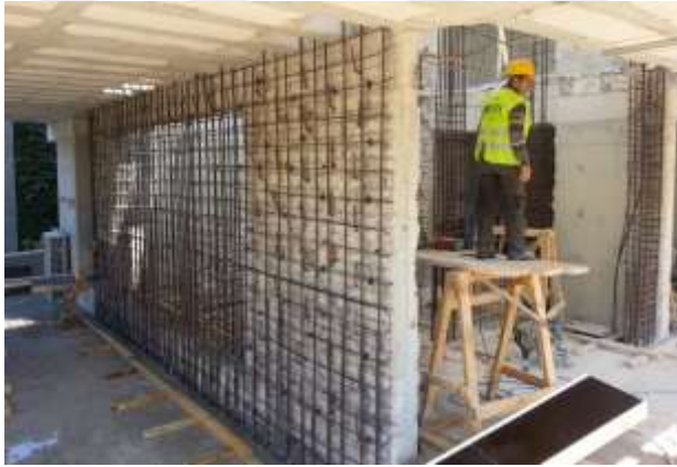
Şekil 2.2. Perde duvarı ile yapılan güçlendirme (Insaport, 2022)
