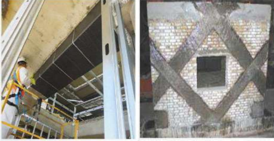
Şekil 2.7. CFRP kumaşı kirişlere uygulama örneği (Boytek, 2019)
