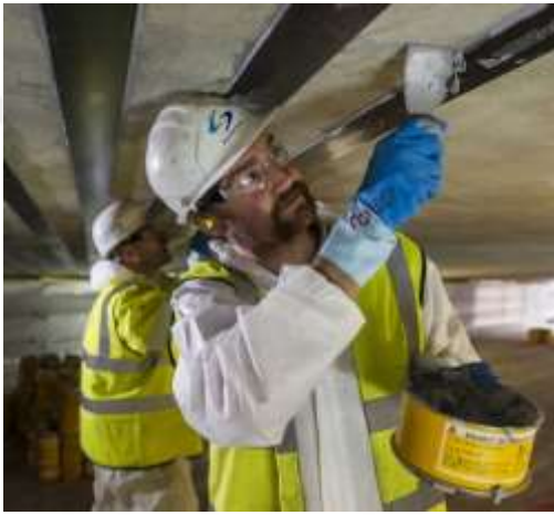
Şekil 2.6. CFRP plakaları (Sika, 2022)
