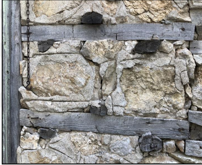
Şekil 49: Dış Duvardaki Hatıl ve Piştuvan Yerleşim Düzeni
