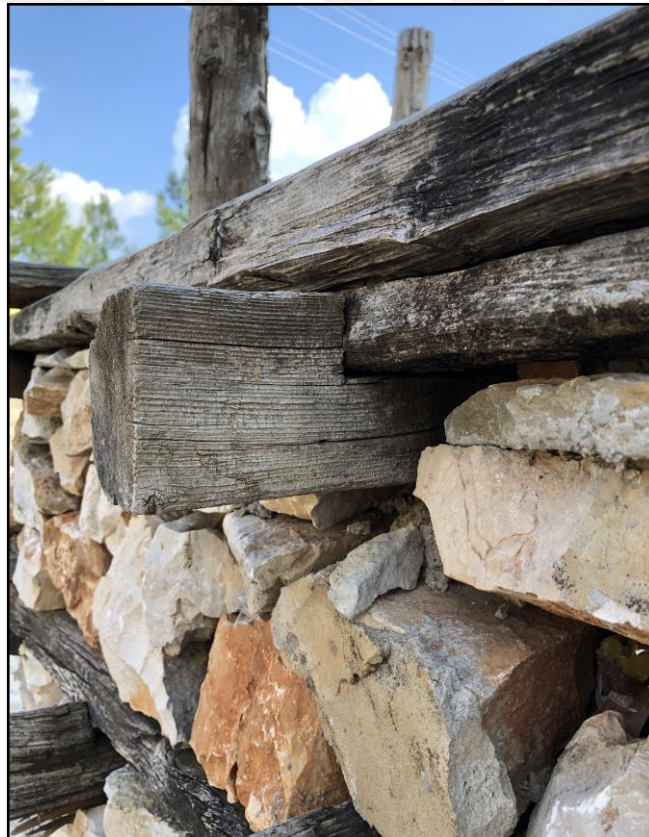
Şekil 39: Piştuvanda Açılan Kertik Detayı
