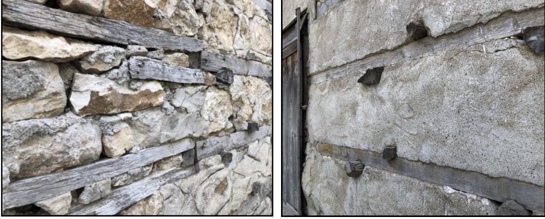
Şekil 35: Dış Cephe Sıvasız ve Sıvalı Görünümü
