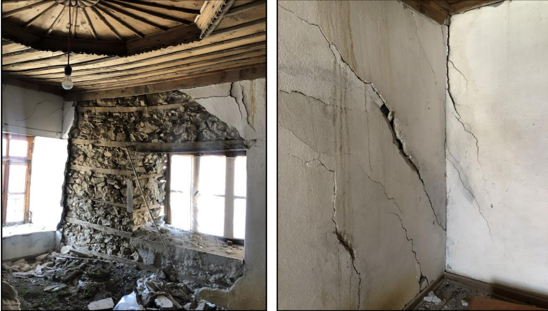
Şekil 36: Bozulan İç Sıva Görünümü
