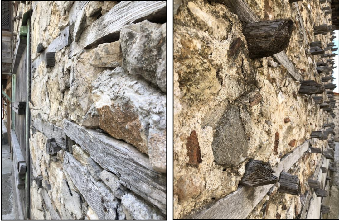
Şekil 27: Taş Duvar Yapım Tekniği
