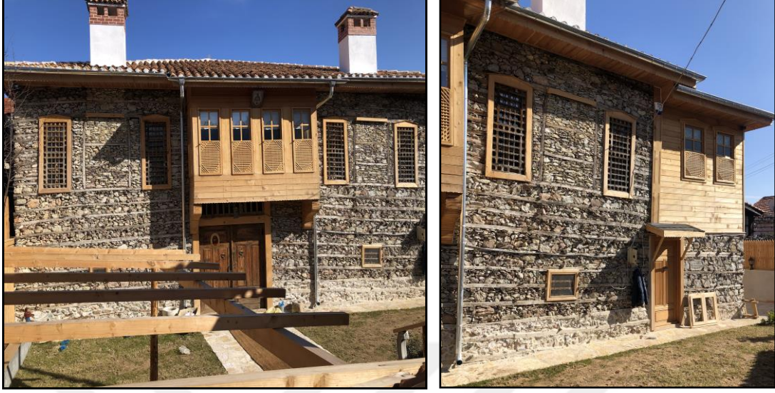
Şekil 111: Yeniçeri Ahmet Ağa Konağı Dış Cephesinin Yeni Hali
