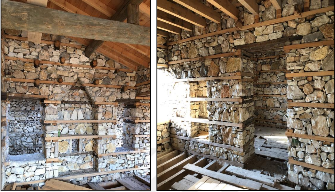
Şekil 105: Geleneksel Tekniklerle İnşa Edilmiş Yeni Yapı
