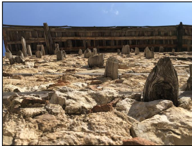
Şekil 50: Duvar Yüzeyinde Düğme (Piştuvan) Görünümü
