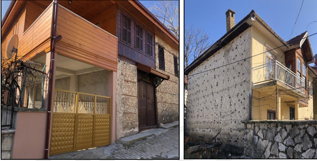
Şekil 100: Farklı Malzeme ve Yapım Teknikleri Kullanılarak Geleneksel Yapılara Eklenen Yeni Kütle Eklerinin Görünümü
