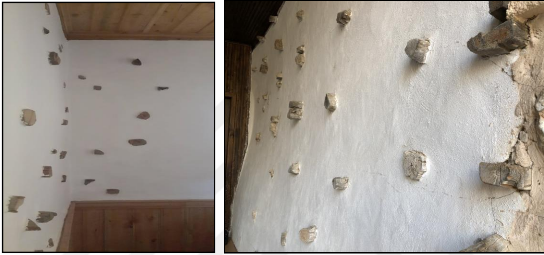
Şekil 32: Sıvalı İç Duvar
