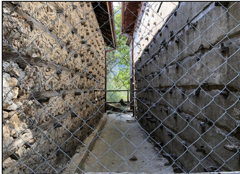
Şekil 34: Dış Cephe Sıvasız-Sıvalı Görünümü
