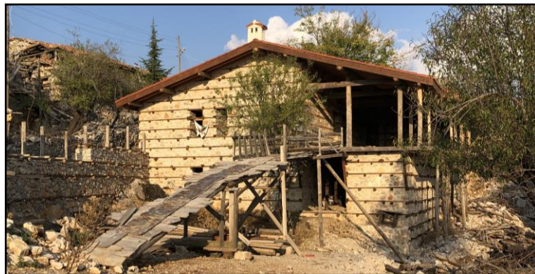
Şekil 104: Geleneksel Tekniklerle İnşa Edilmiş Yeni Yapı
