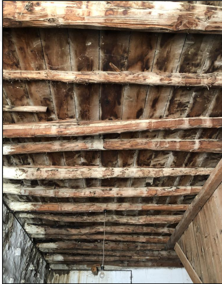
Şekil 51: Zemin Kat Tavan Döşemesindeki Merdekler
