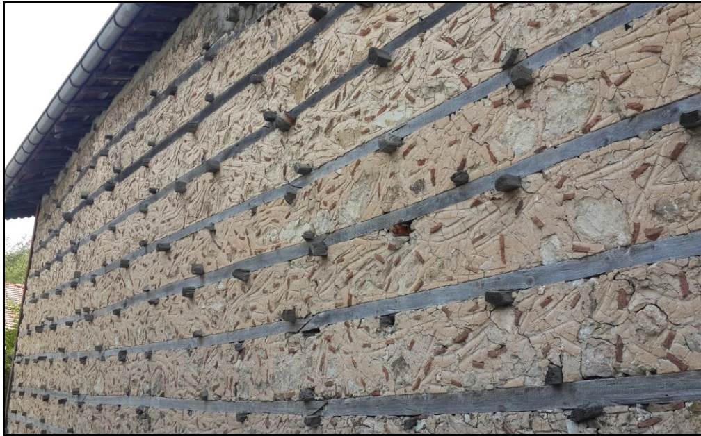
Şekil 21: Düğmeli Evler’de Duvar İnşa Tekniği
