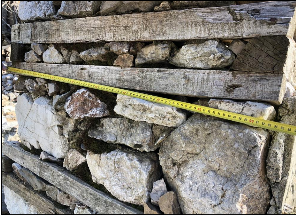
Şekil 45: Duvar Örgü Detayındaki Taş Boyutları
