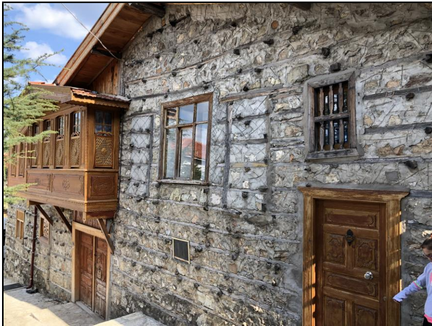
Şekil 31: Duvar Örgüsünde Ahşap Elemanlar
