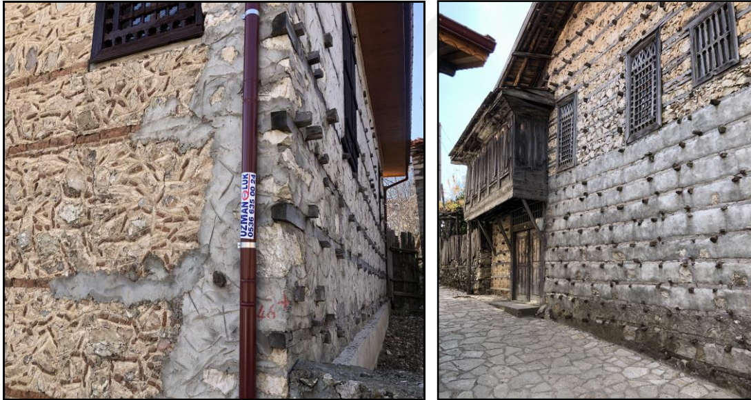
Şekil 99: Geleneksel Yapıda Çimento Esaslı Sıva Kullanımları
