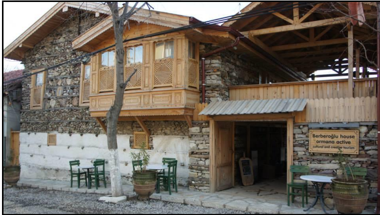
Şekil 107: Restorasyon Örneği(Dış Cephe)
