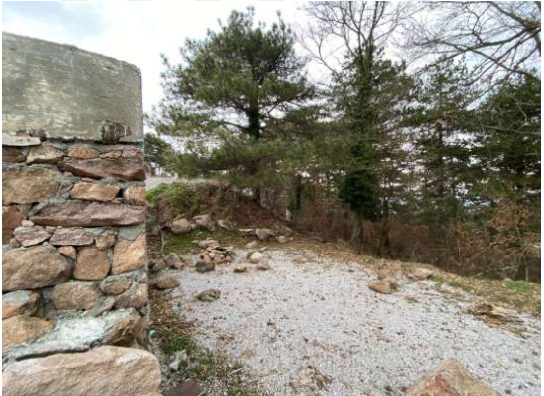
Fotoğraf 47. Kertilde İnşaat Alanı (2)
