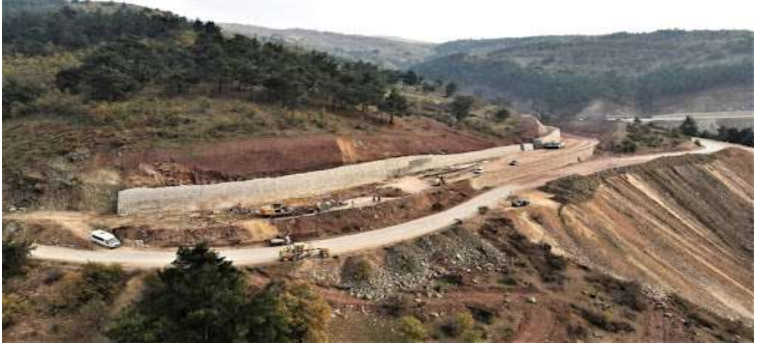
Fotoğraf 12. Sındırgı-Akhisar Karayolu Yol Yapım Çalışmaları
