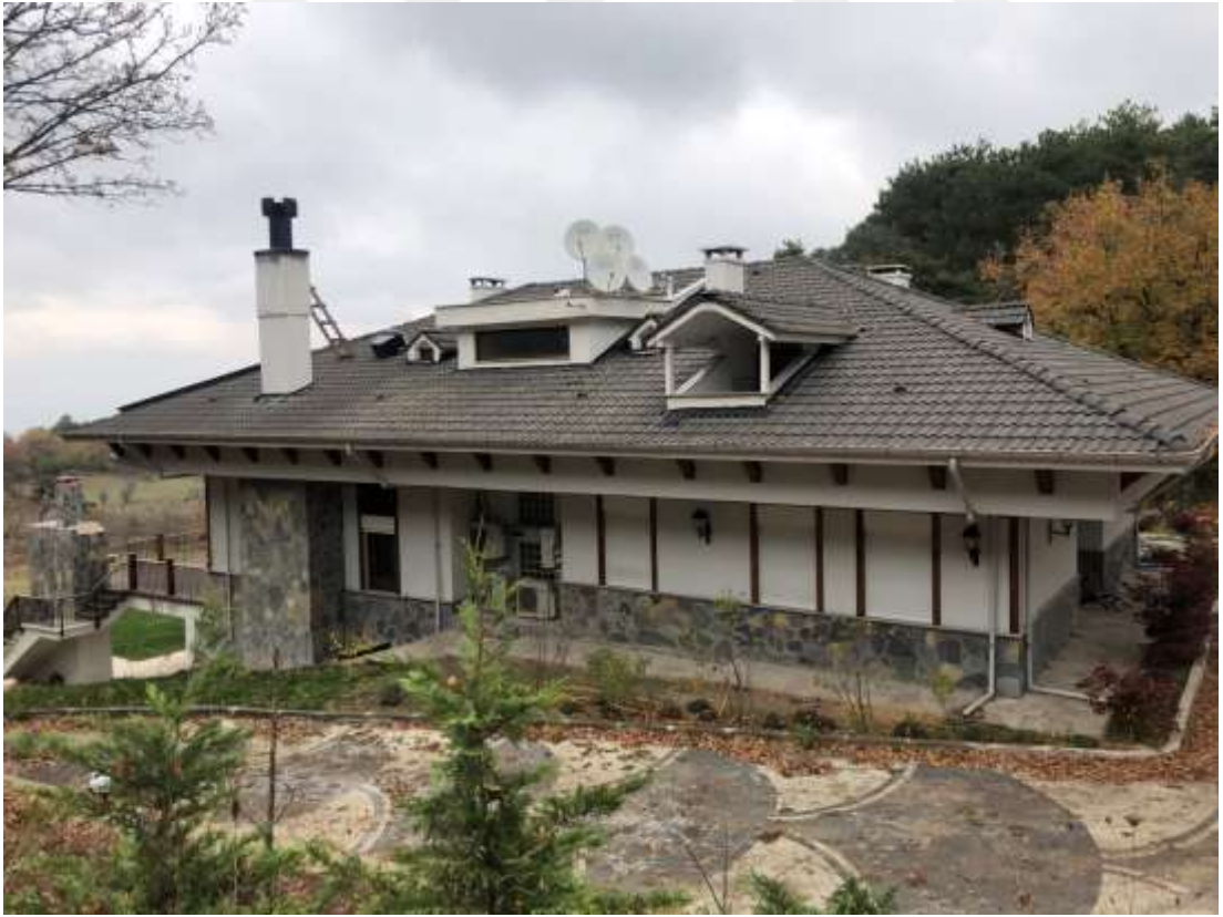
Fotoğraf 44. Kertilde Etrafı Duvarla Çevrili Dupleks Konut Alanı
