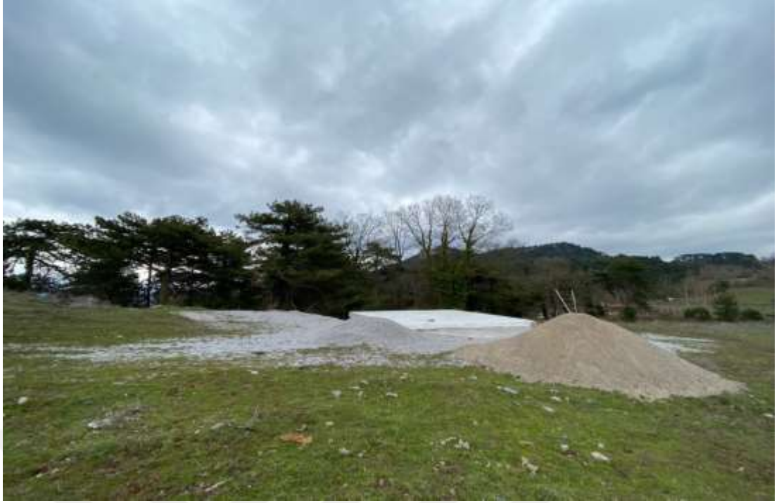
Fotoğraf 46. Kertilde İnşaat Alanı
