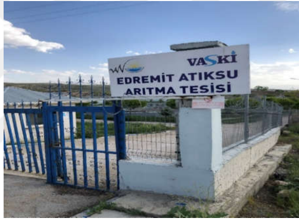
Şekil 12. Van ili merkez Edremit ilçesi atık su arıtma tesisi
