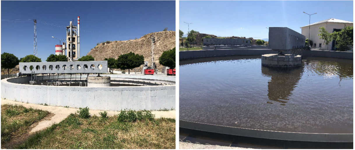
Şekil 15. Atık su arıtma tesisinin ön çökeltim ve havalandırma havuzları
