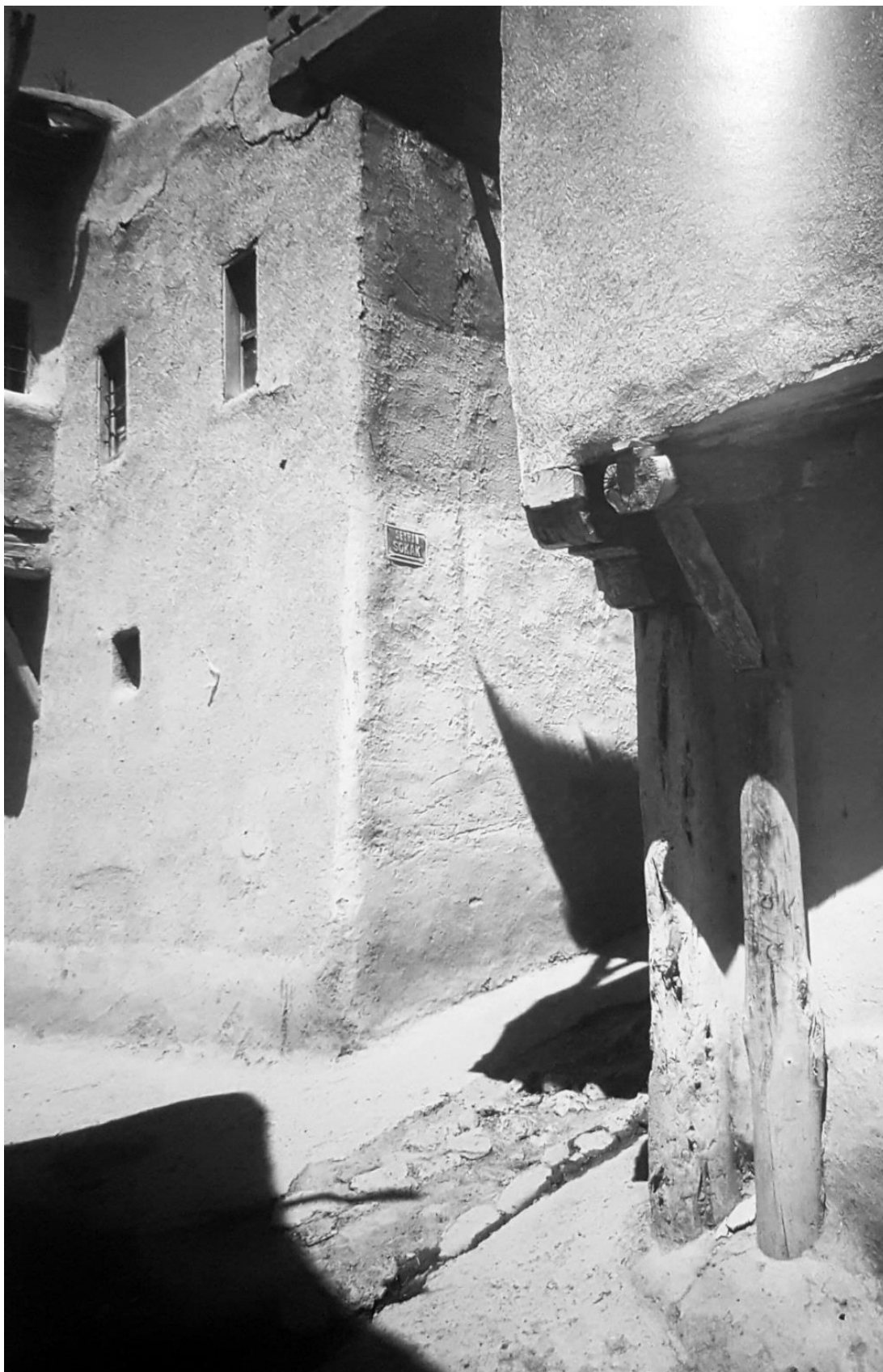
Imagen 81. Un ejemplo del uso del adobe en Anatolia central, Balaban.
