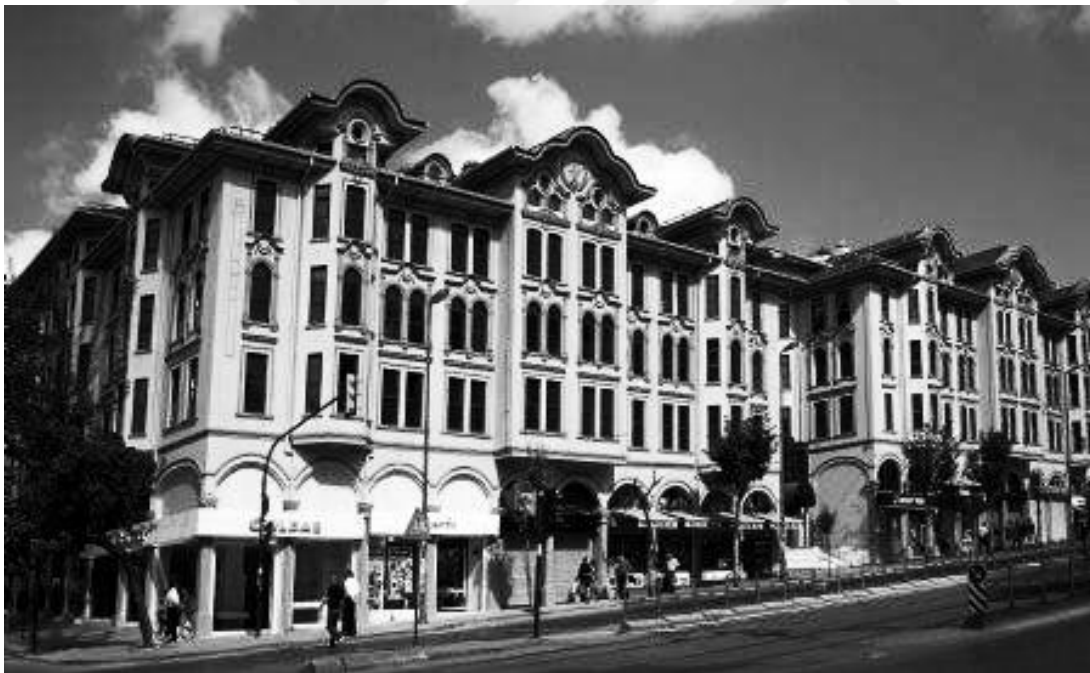
Imagen 97. Los edificios de Harikzedegan, estado actual.
