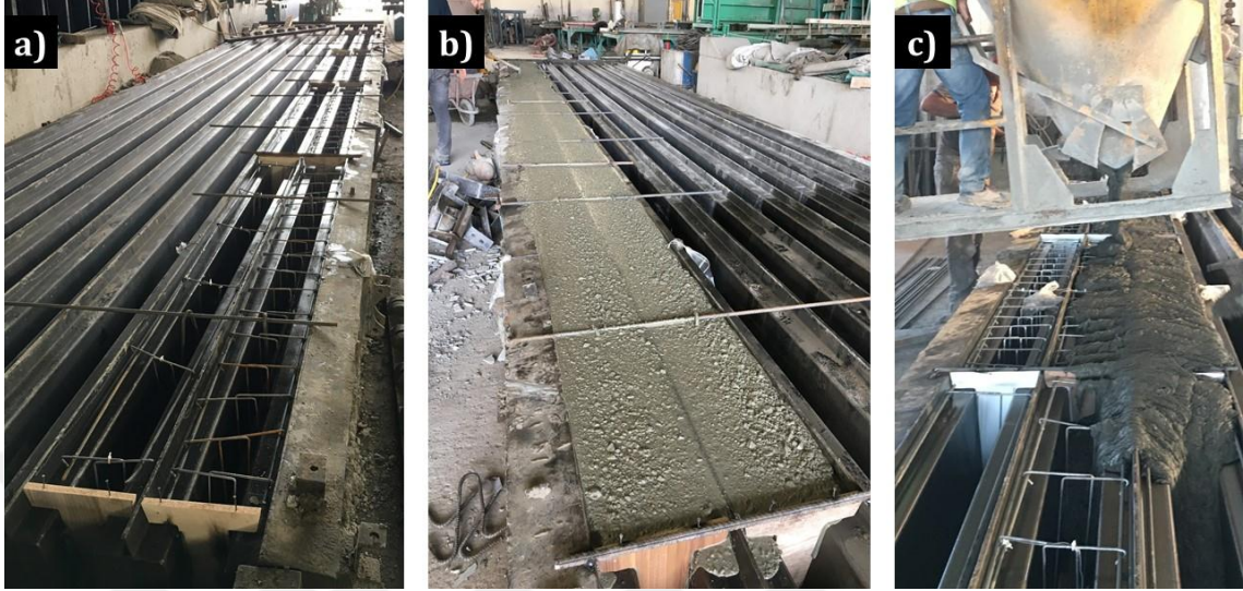
Şekil 5.18 : Kirişlerin üretimi a) beton dökümü öncesi b) geleneksel beton dökümü c) UYPB dökümü.
