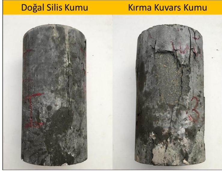
Şekil 6.14 : DS ve KK kumu içeren UYPB numunelerinin basınç altındaki hasar görünüşleri.
