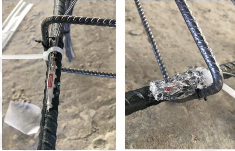
Şekil 5.16 : Gerinim pullarının yapıştırılması.
