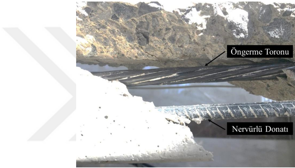
Şekil 6.27 : Deney sonrası kiriş içerisindeki donatı ve toronun görünümü (N serisi).
