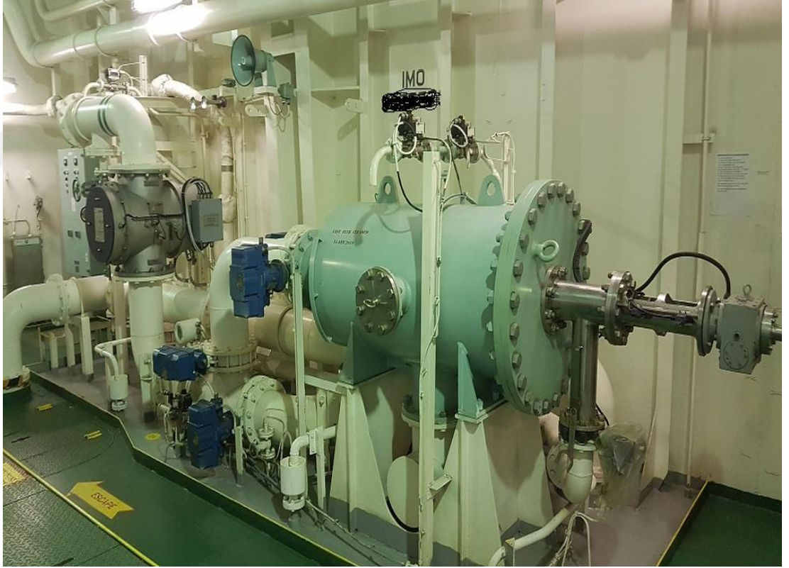
Şekil 2.13 Gemi montajı tamamlanmış balast arıtım cihazı
