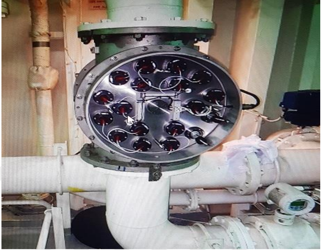
Şekil 2.14 Balast arıtım cihazında arıtım işlemi yapan probalar
