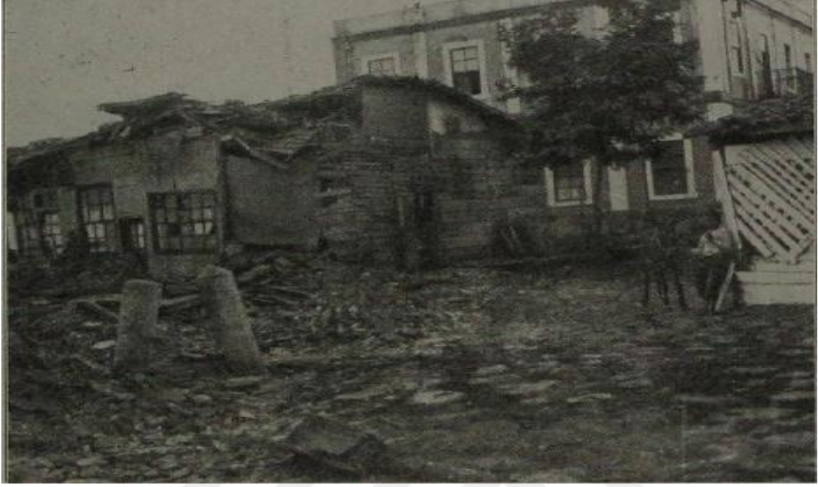
Resim 2: Tekirdağ'da Tamamen Yıkılan Gemerek Camii Enkazı 293
