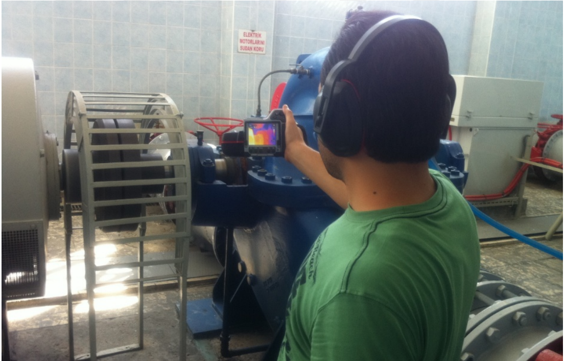
Şekil 3.15. Motopomp Kaplin ve Yatak Sıcaklıklarının Termal Kamera ile Ölçümü.
