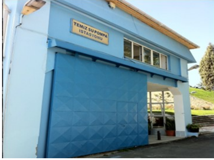
Şekil 3.1. Kağıthane Terfi Merkezi Girişi.
