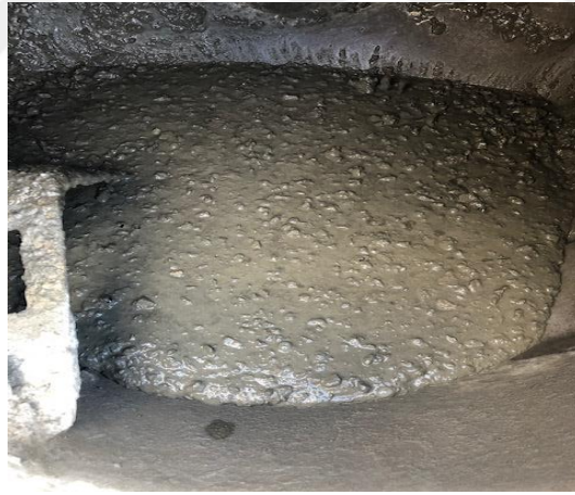
Şekil 3.4. Betoniyer içindeki karışım durumu.
