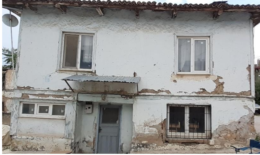
Şekil 4. 25 Pencere oranlarının değişimi ve PVC pencere doğrama, E011, (Doğan Talyak, 2021)
