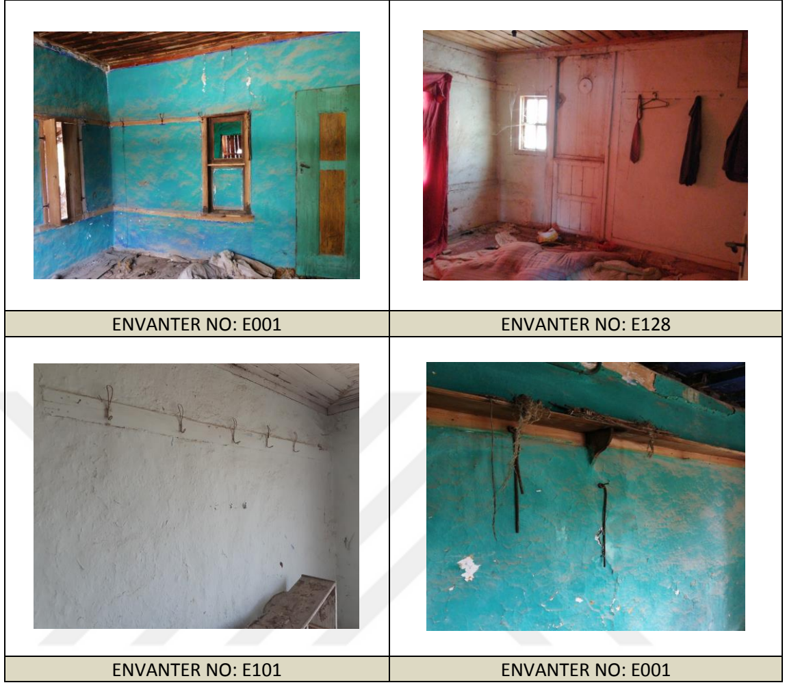
Şekil 3. 73 Elbeyli geleneksel yapı askılık örnekleri, (Doğan Talyak, 2021)
