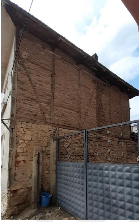
Şekil 3. 49 Zemin kat ahşap hatıllı yığma moloz taş, E015, (Doğan Talyak, 2021)
