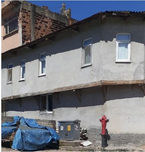
Şekil 4. 14 Çimento sıva uygulaması, E052(Doğan Talyak, 2021)
