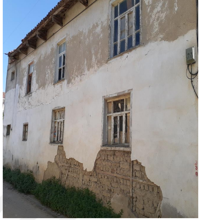
Şekil 3. 50 Zemin kat ahşap karkas sistem arası kerpiç tuğla dolgu, E108, (Doğan Talyak, 2021)
