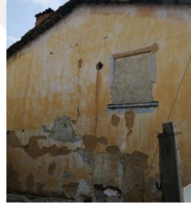
Şekil 4. 27 Pencere boşluğunun özgün olmayan malzeme ile kapatılması, E005, (Doğan Talyak, 2021)
