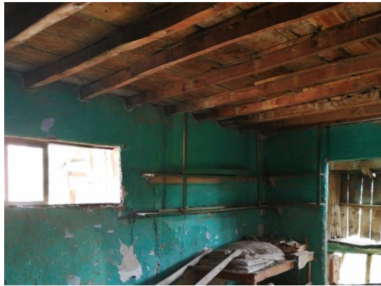
Şekil 3. 41 Döşeme kirişlerinin açıkta olduğu tavan uygulaması, E001, (Doğan Talyak, 2021)
