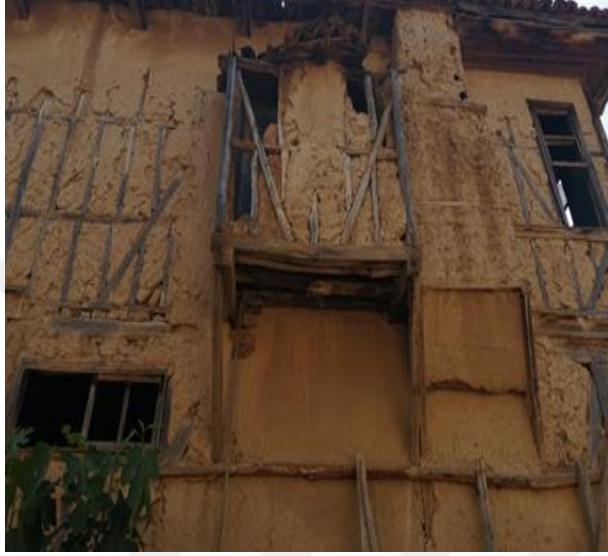
Şekil 4. 16 Kerpiç malzeme kaybı, E001, (Doğan Talyak, 2021)
