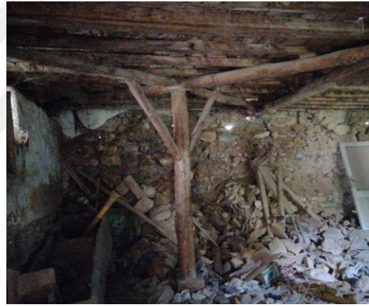
Şekil 3. 44 Bodrum kat çapraz kiriş, E001, (Doğan Talyak, 2021)
