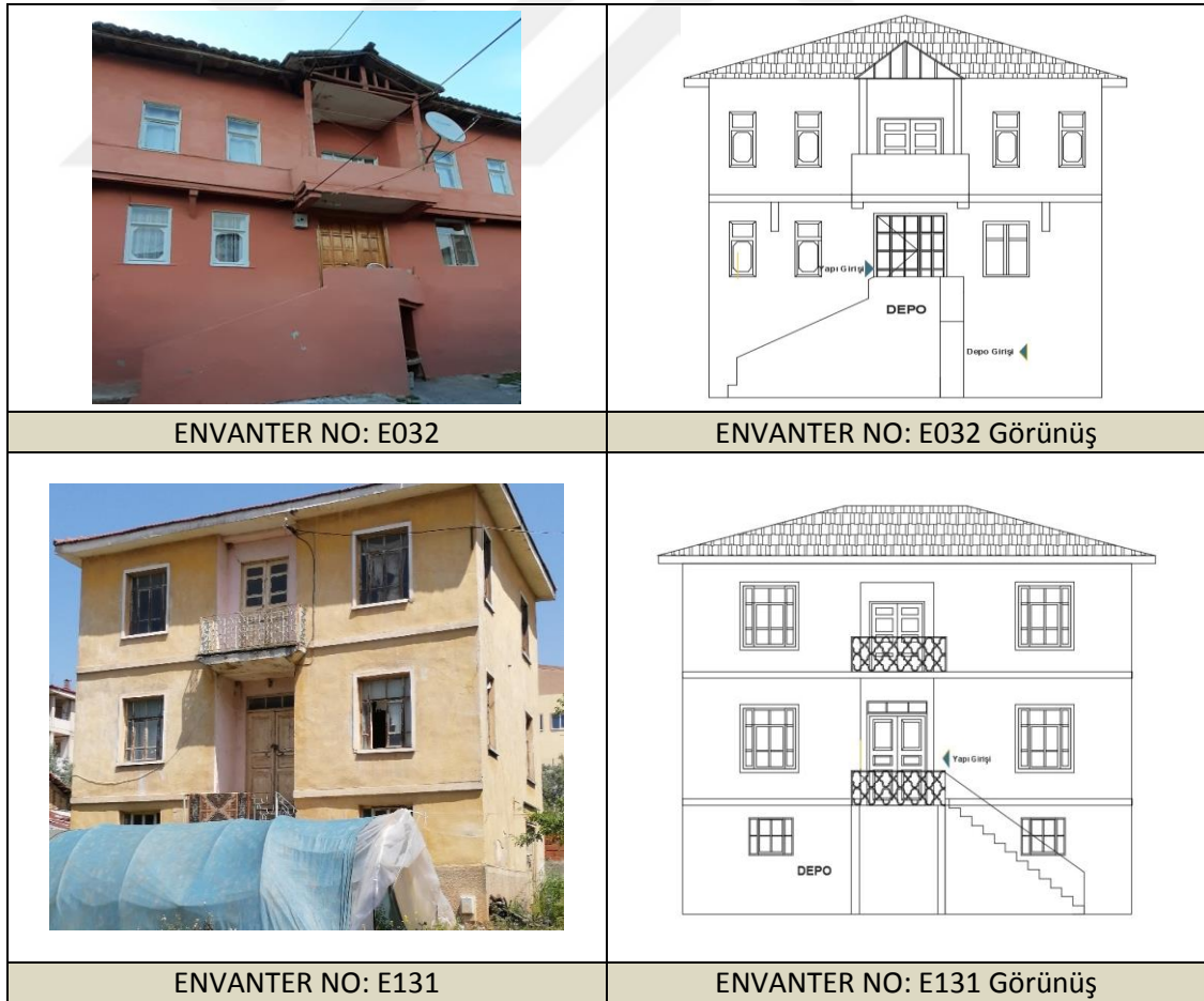
Şekil 3. 87 Zemin katı depo / ahır kullanımlı yapı ve görünüşleri, (Doğan Talyak, 2021)
