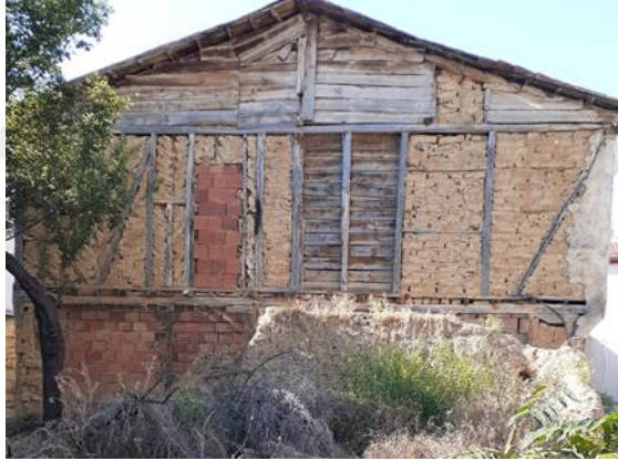
Şekil 4. 26 Cephe onarımında tuğla ile yapılan müdahale, E003, (Doğan Talyak, 2021)
