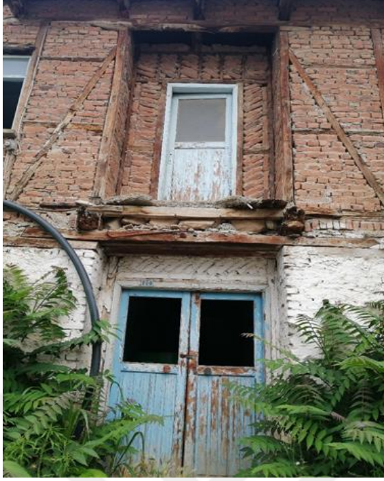
Şekil 3. 51 Harman tuğla uygulaması, E023, (Doğan Talyak, 2021)
