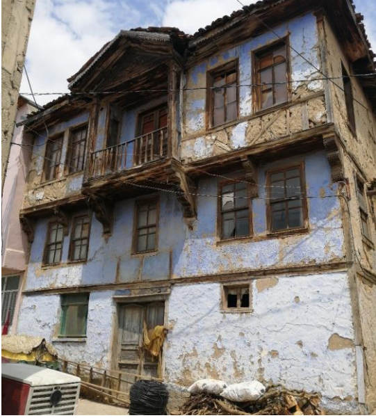
Şekil 3. 95 Ara katlı yapı örneği, E018, (Doğan Talyak, 2021)
