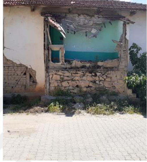
Şekil 4. 17 Ahşap karkas sistemde görülen kopmalar, E106, (Doğan Talyak, 2021)
