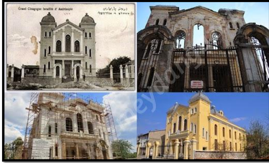
Şekil 2.6. Edirne Büyük Sinagog' unun restorasyon öncesi, restorasyon sırasındaki ve restorasyon sonrasındaki hali (Anonim, 2021d).
