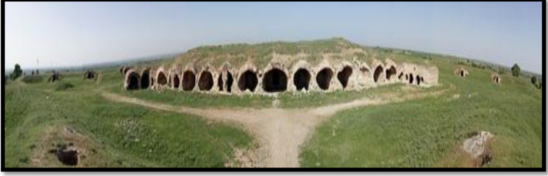
Şekil 2.30. Hıdırlık Tabyası iç avlusunun restorasyon öncesi görüntüsü (KVMGM, 2021).
