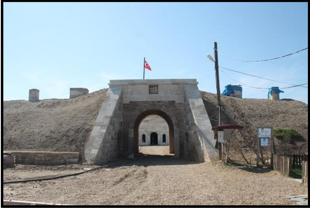
Şekil 2.33. Hıdırlık Tabyaları nizamiye ana giriş binası restorasyon esnasındaki görüntüsü (KVMGM, 2021).
