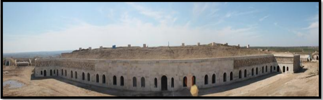
Şekil 2.31. Hıdırlık Tabyası iç avlusunun restorasyon esnasındaki görüntüsü (KVMGM, 2021).
