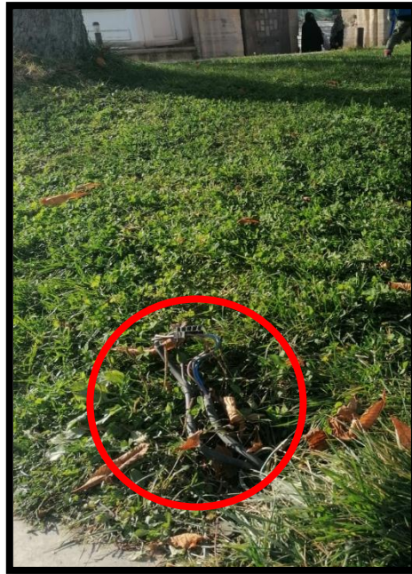
Şekil 3.24. Selimiye Cami bahçesindeki açıkta bırakılan elektrik kabloları.
