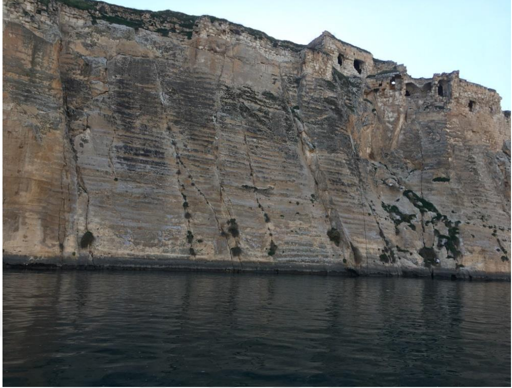
Şekil 3.3.2. İstasyonun görüntüsü (Rumkale, Halfeti/ŞANLIURFA 2016 Serdar ERGÜNAL)
