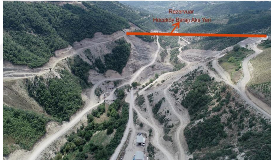
Şekil 3.2. Hocaköy Barajı inşaat alanı mansaptan membaya doğru görünümü (Özgün, 2019)
