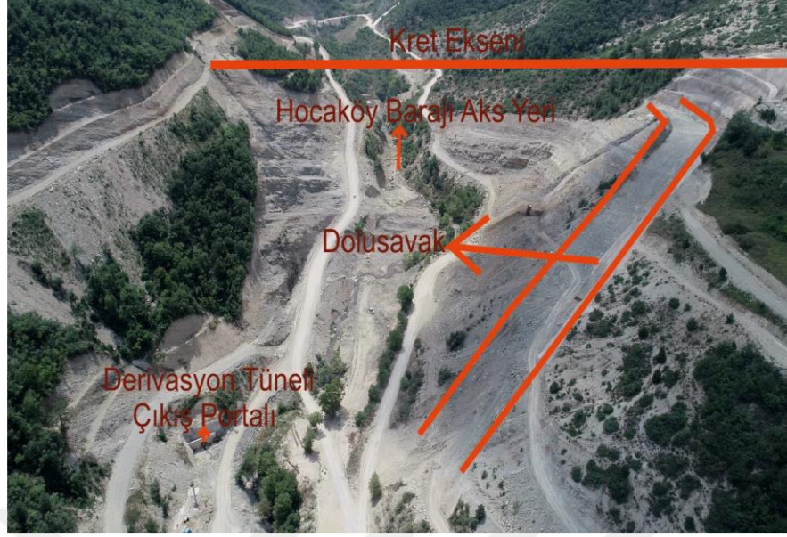
Şekil 3.1. Hocaköy Barajı inşaat alanı mansaptan görünümü (Özgün, 2019)
