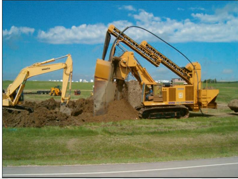
Şekil 2. 2 Güney Dakota'daki Ellsworth Hava Kuvvetleri Üssü'nde çalışan sürekli tek geçişli hendek kazıcı (AFCEE, 2008)
