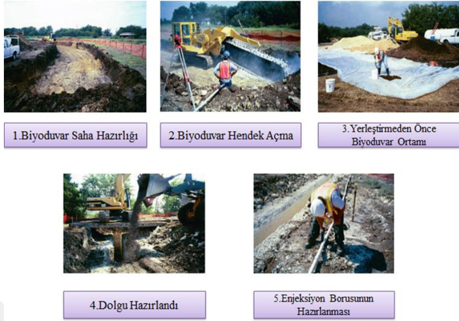
Şekil 2. 3.NWIRP McGregor 'da biyodüvar inşaatı (NAVFAC Southeast,2009)
