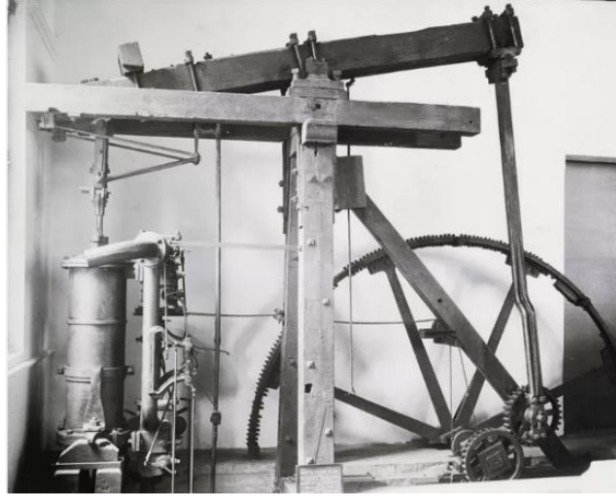
Şekil 2.3 James Watt' ın Geliştirdiği Buhar Makinesi (Van der Kooij, 2015)
