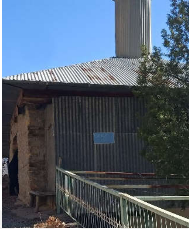
Şekil 67. Koçan (Hacı Mehmet Ağa) Caminin kuzey cephesindeki sac kaplama üzerinde bulunan metal levha
