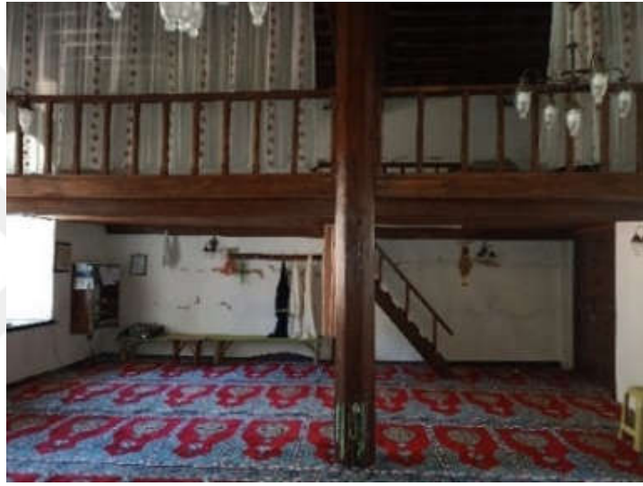
Şekil 27. Bahçe Mahallesi Cami harim kuzey iç cephesi
