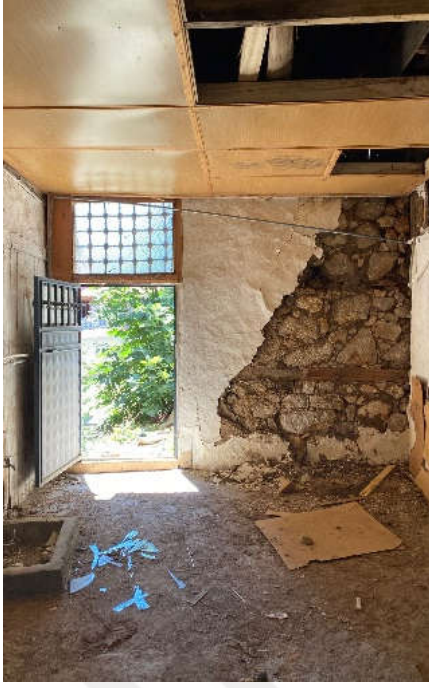
Şekil 118. Lojman: Giriş: Kuzey iç cephesi
