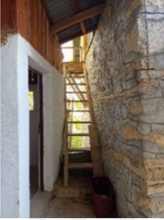
Şekil 59. Caminin kuzey cephesinde bulunan ve minareye ulaşımı sağlayan ahşap merdiven
