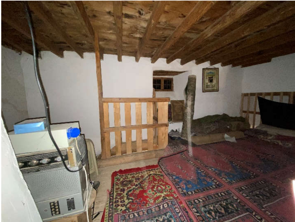
Şekil 167. Mahfil: Kuzey iç cephesi
