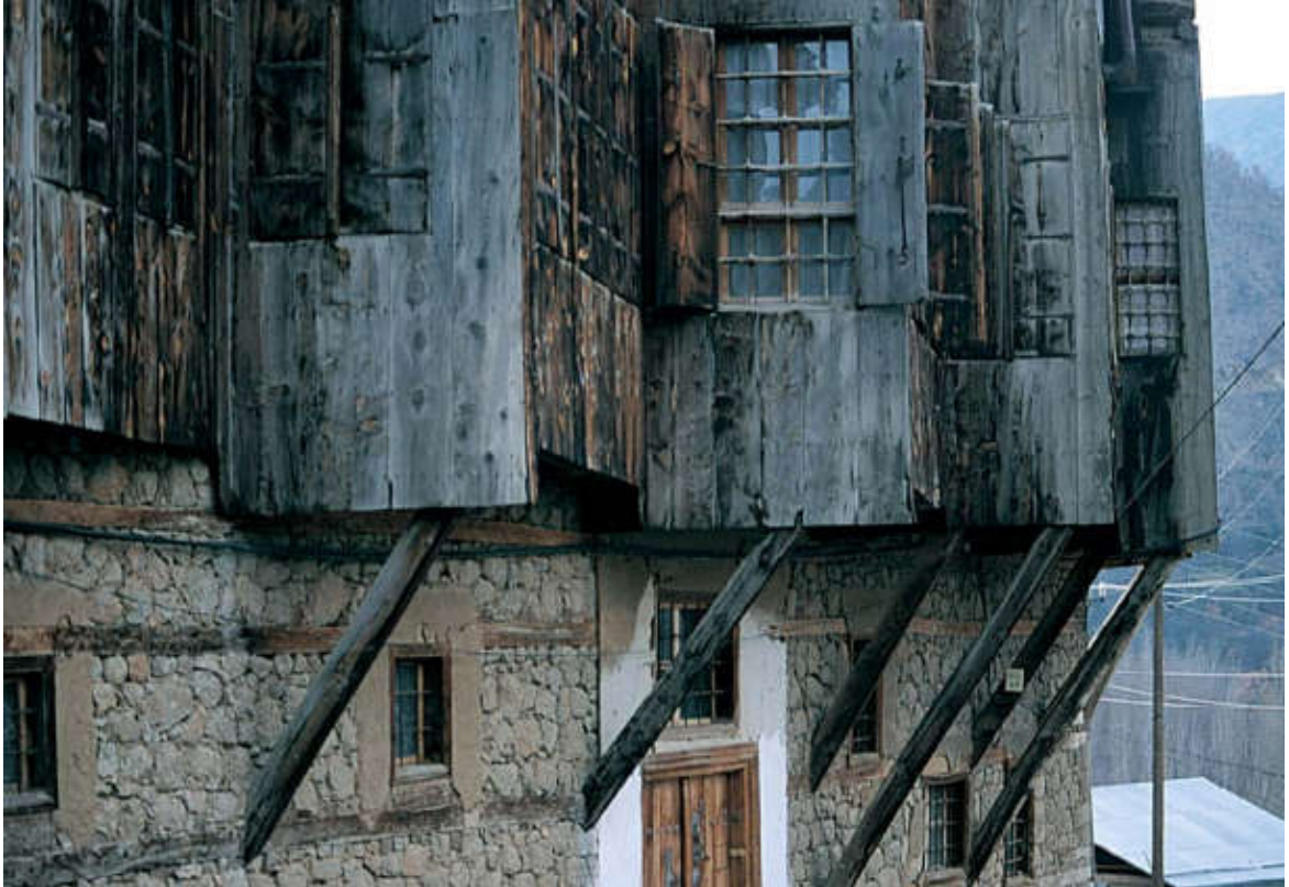
Şekil 18. Geleneksel konutun yapım tekniği (Vural 2010)
