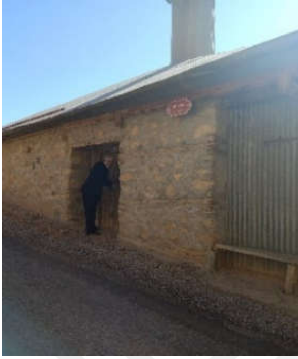
Şekil 68. Koçan Caminin kuzey cephesinde bulunan oda giriş kapısı
