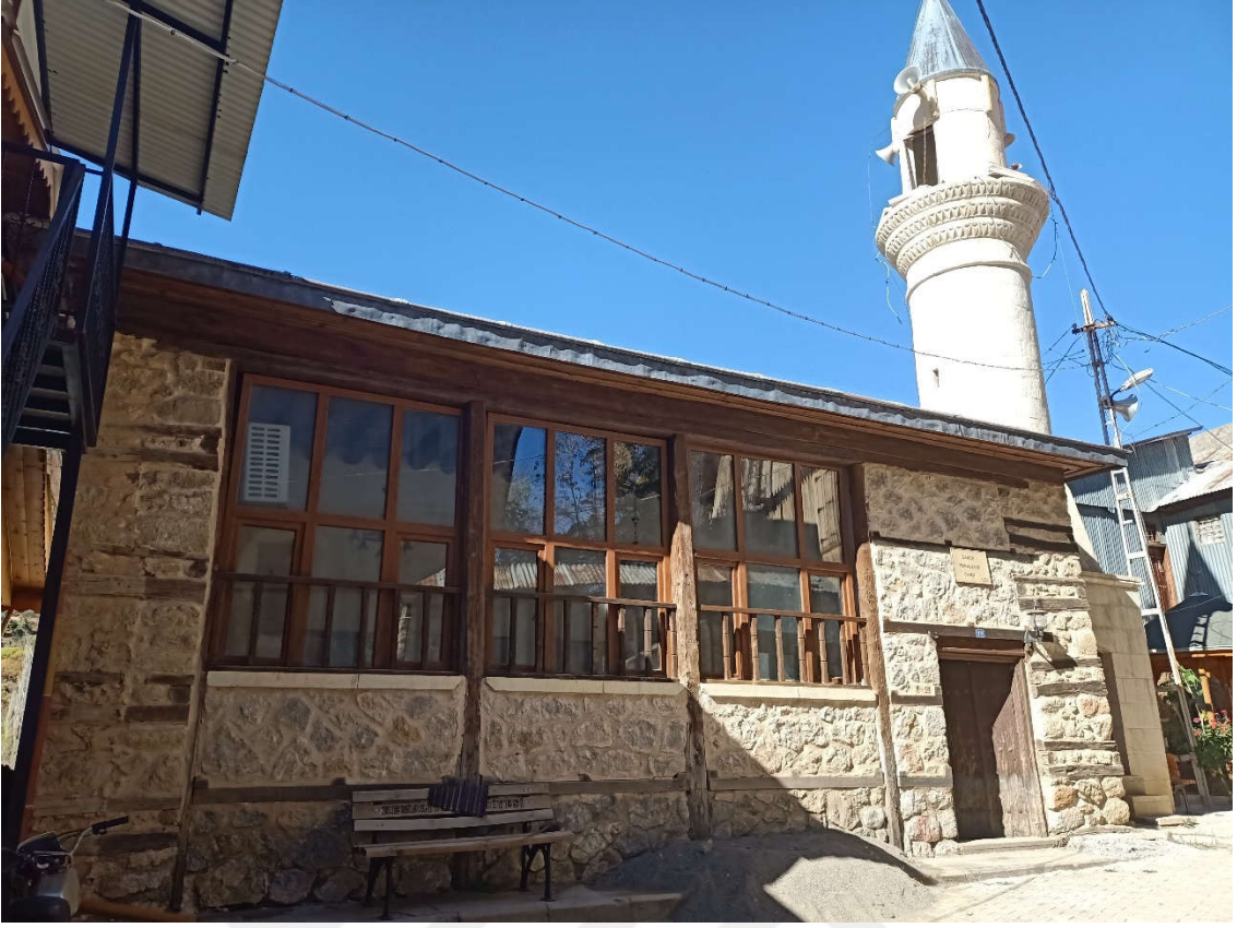
Şekil 96. Bahçe Mahallesi Cami giriş cephesi
