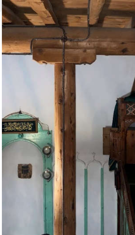
Şekil 159. Harim: Ahşap dikme ve ahşap sütun başlığı
