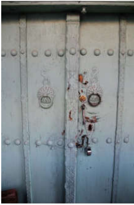
Şekil 180. Cami giriş kapısı ön görünüşü
