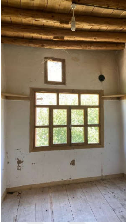
Şekil 132. Lojman: Oda 3: Batı iç cephesi
