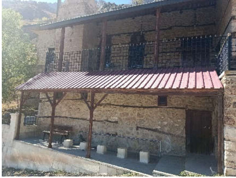
Şekil 81. Taşdibi Cami doğu cephesi
