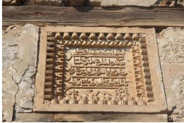
Şekil 30. Embiyabey Camisinin doğu duvarı üzerinde bulunan tadilat kitabesi
