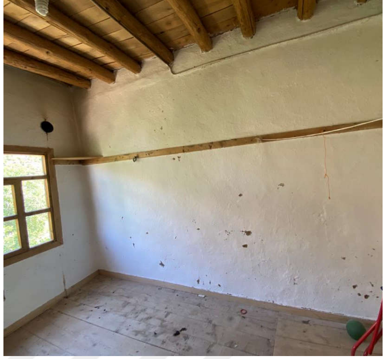
Şekil 133. Lojman: Oda 3: Kuzeybatı iç cephesi
