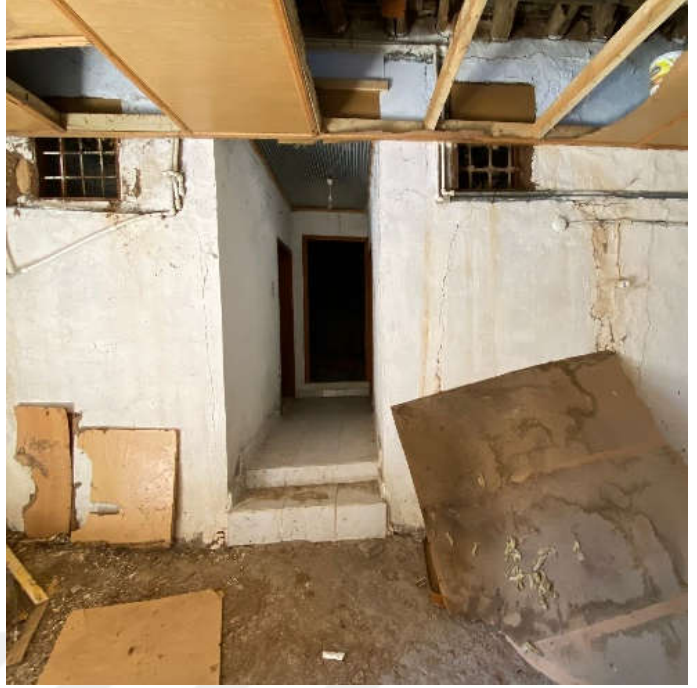
Şekil 119. Lojman: Giriş: Doğu iç cephesi
