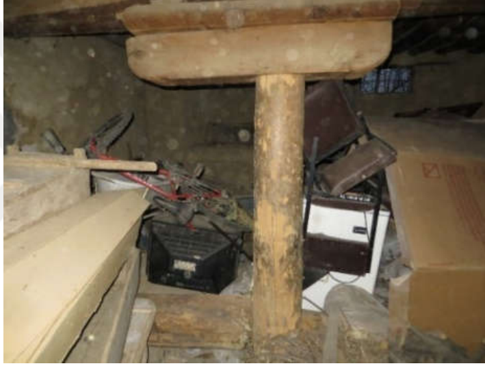
Şekil 49. Hacı Emin Efendi Mescidi deposunda bulunan ahşap dikme ve ahşap sütun başlığı
