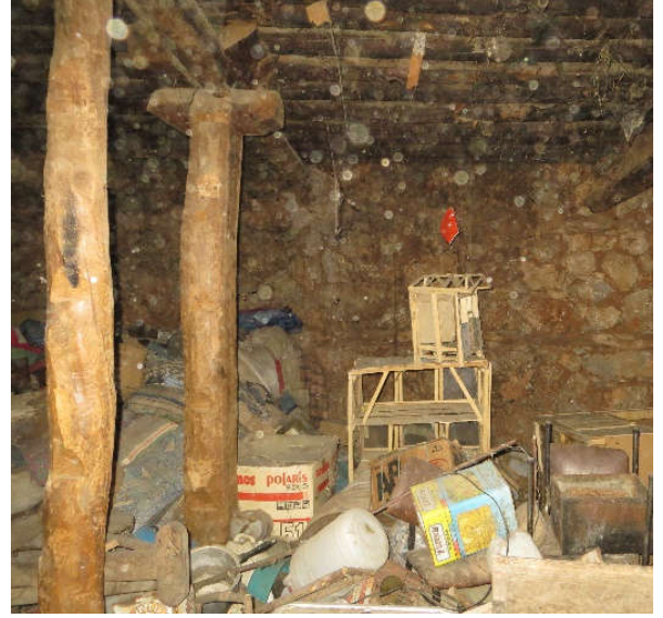
Şekil 108. BO1 Depo: Batı iç cephesi
