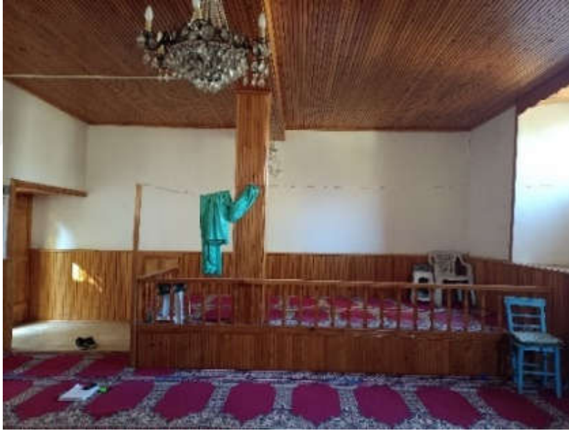
Şekil 66. İhsaniye Cami harimi kuzey iç cephesi
