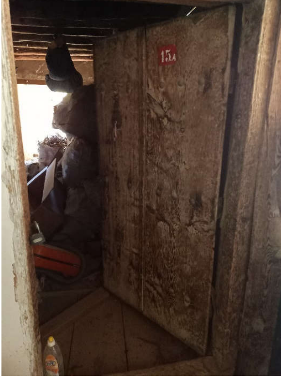
Şekil 72. Koçan Cami depo kapısı
