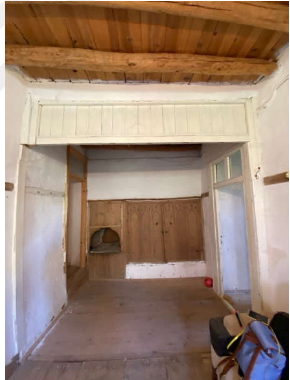
Şekil 127. Lojman: Oda 2: Doğu iç cephesi
