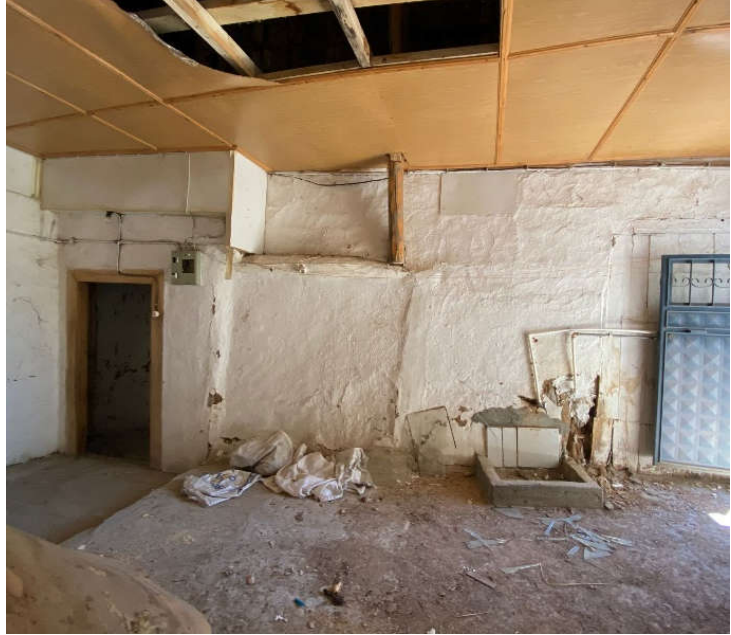
Şekil 117. Lojman: Giriş: Batı iç cephesi
