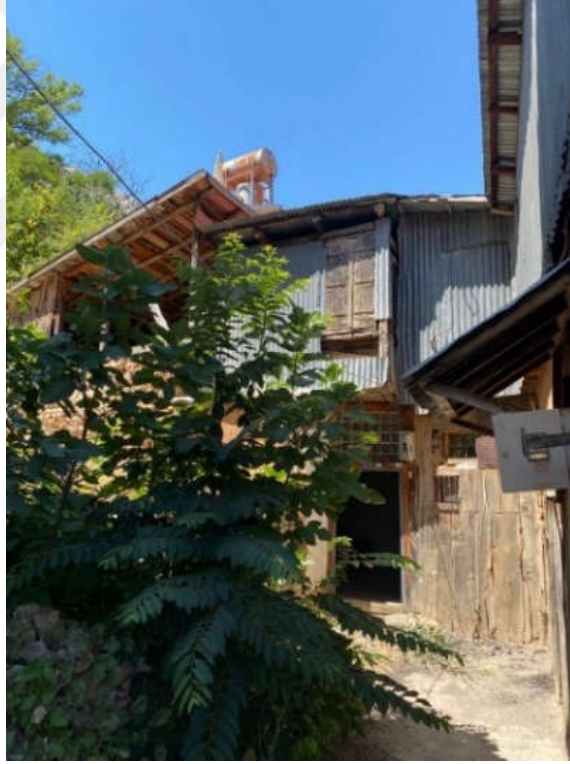
Şekil 175. Güney cephesi (Lojman giriş cephesi)
