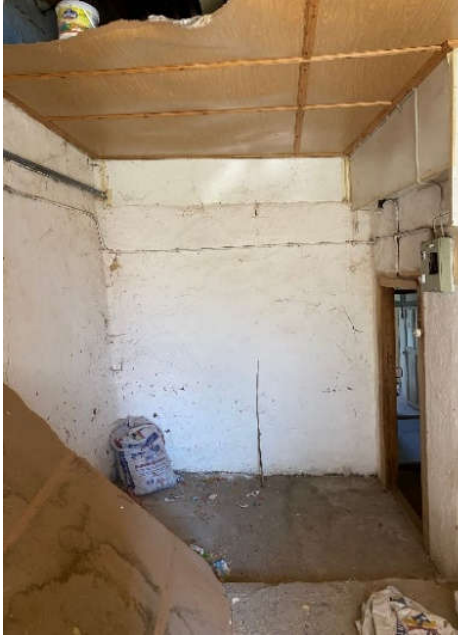
Şekil 116. Lojman: Giriş: Güney iç cephesi
