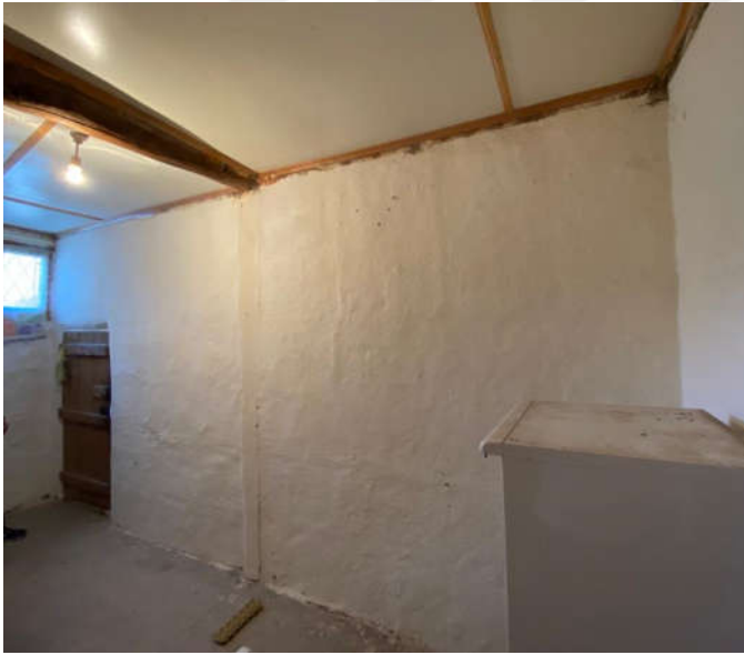
Şekil 142. Lojman: Mutfak: Güneybatı iç cephesi
