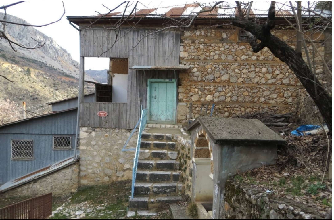
Şekil 99. Kurtoğlu Cami giriş cephesi
