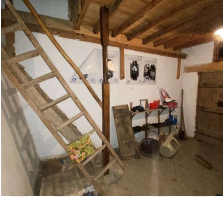
Şekil 152. Son cemaat mahali kuzey iç cephesi
