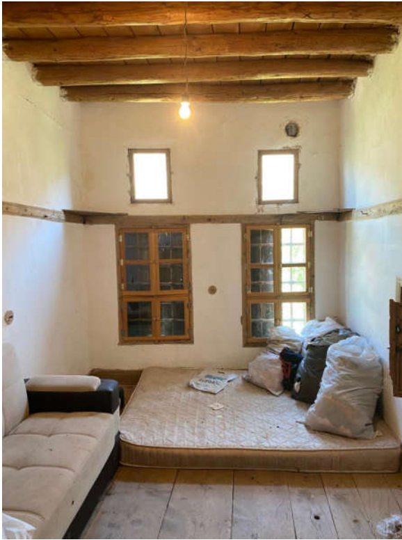
Şekil 126. Lojman: Oda 2: Batı iç cephesi
