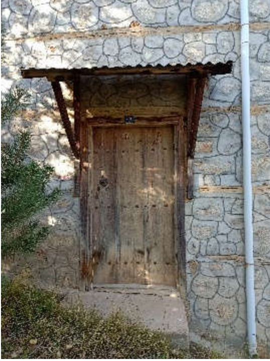
Şekil 63. İhsaniye Cami güney cephesinde bulunan depo giriş kapısı
