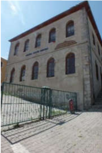
Şekil 8. Eski ilkokul binası (Yapan 2021)
