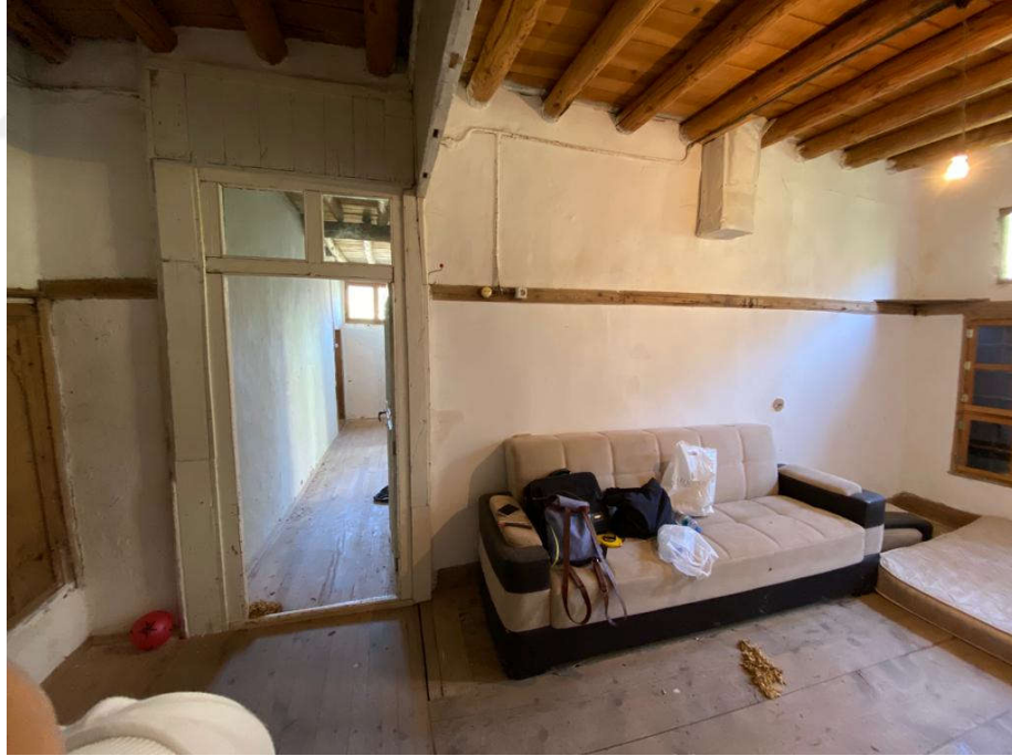
Şekil 124. Lojman: Oda 2: Güney iç cephesi
