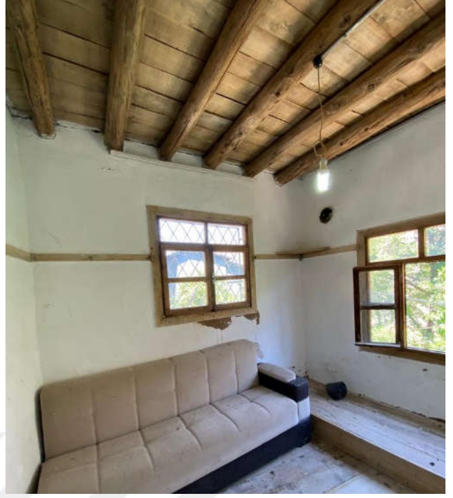
Şekil 137. Lojman: Oda 4: Güneybatı iç cephesi
