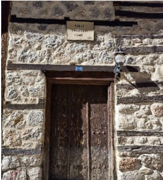
Şekil 19. Bahçe Mahallesi Cami son cemaat mahali kapısının üzerinde bulunan metal levha
