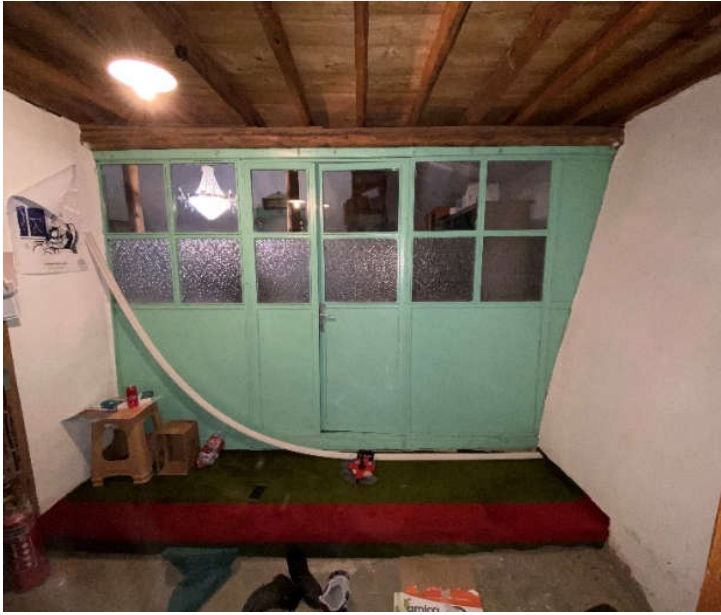
Şekil 154. Son cemaat mahali: Güney iç cephesi
