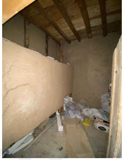
Şekil 145. Lojman: Oda 5: Kuzeybatı iç cephesi
