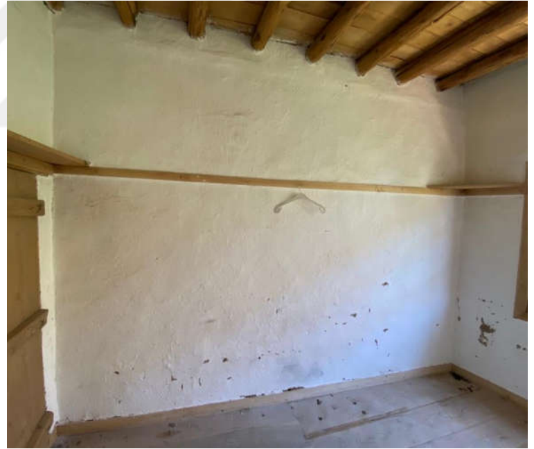
Şekil 135. Lojman: Oda 3: Güney iç cephesi
