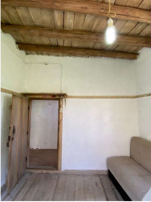
Şekil 138. Lojman: Oda 4: Doğu iç cephesi
