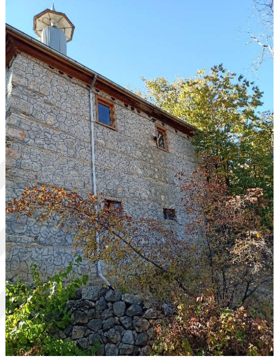
Şekil 64. İhsaniye Cami doğu cephesi
