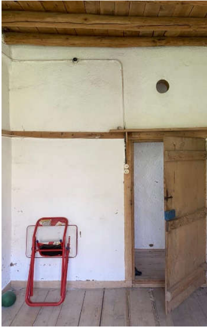
Şekil 134. Lojman: Oda 3: Doğu iç cephesi
