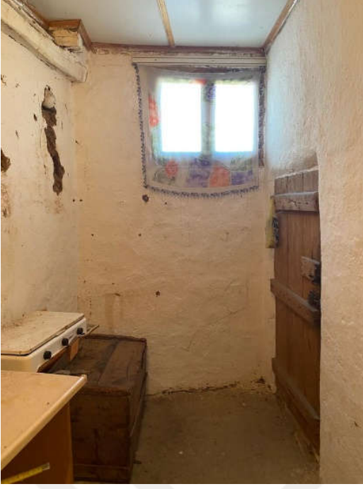
Şekil 144. Lojman: Mutfak: Güney iç cephesi
