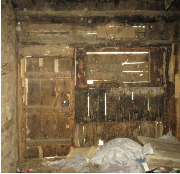
Şekil 107. BO1 Depo: Doğu iç cephesi
