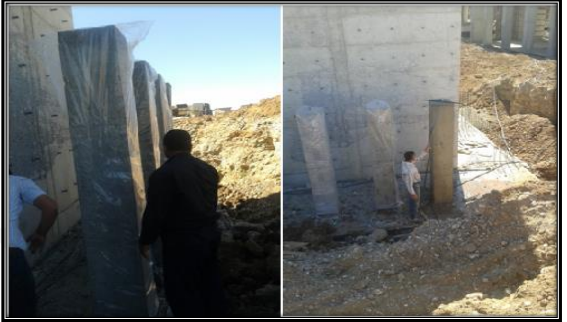
Şekil 4.5. Kolon numunelerin şantiyede kür edilmesi ve korunması
