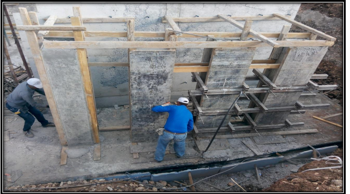
Şekil 4.4. Beton kalıplarının sökülmesi
