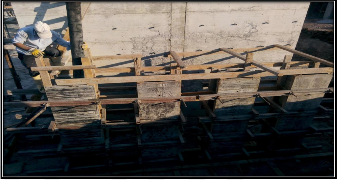
Şekil 4.3. Botunun kalıplara dökülmesi
