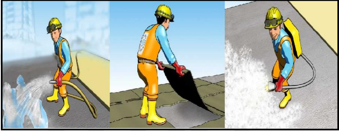
Şekil 2.5. Beton kür işlemi (THBB 2013).
