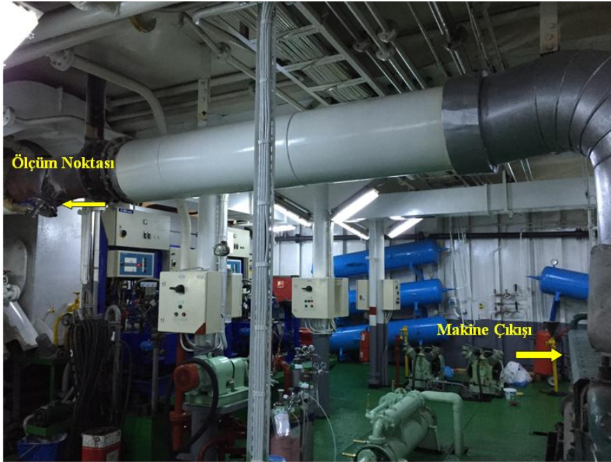
Şekil 3.5 : Egzoz bacası ve emisyon ölçüm noktası.
