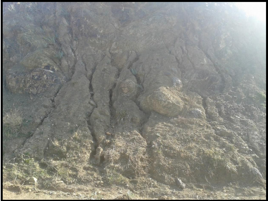
Şekil 82: Araştırma sahası güneyinde yol yarmasında parmak erozyonu oluşumu.
