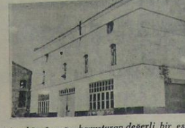
Uzunköprü ışığa kavuşturulan değerli bir eser Elektrik santrali
