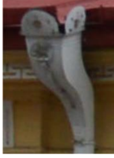
Fotoğraf 19: Ortakapı Mahallesi 191 Numaralı Konutun Çörten Detayı
