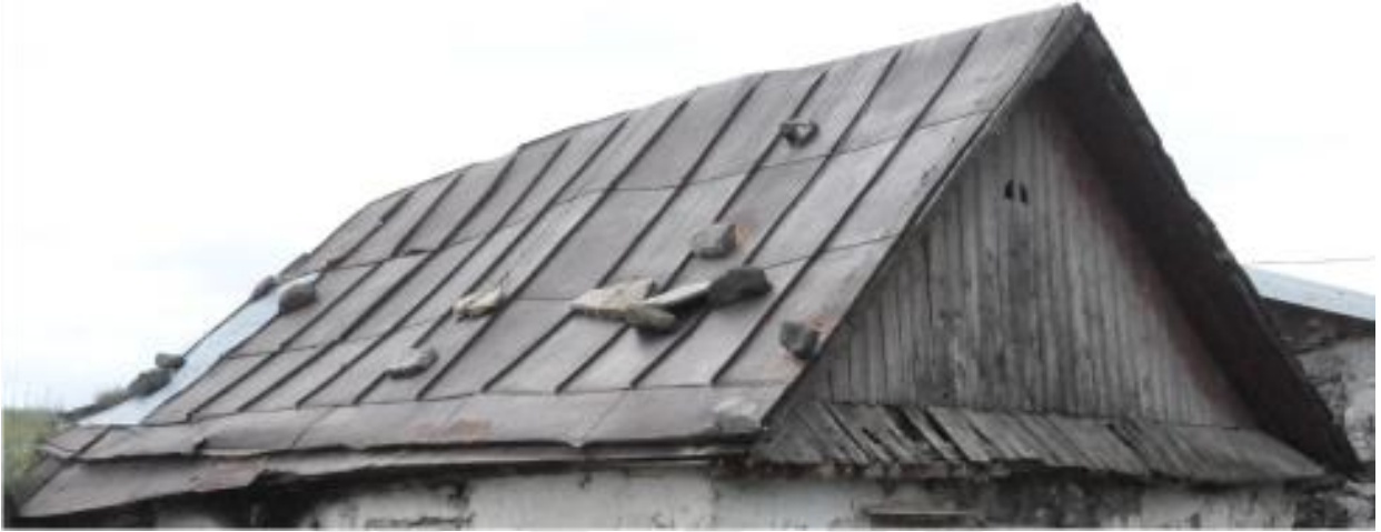
Fotoğraf 15: Çakmak Köyü Malakan Evi Çatı Detayı
