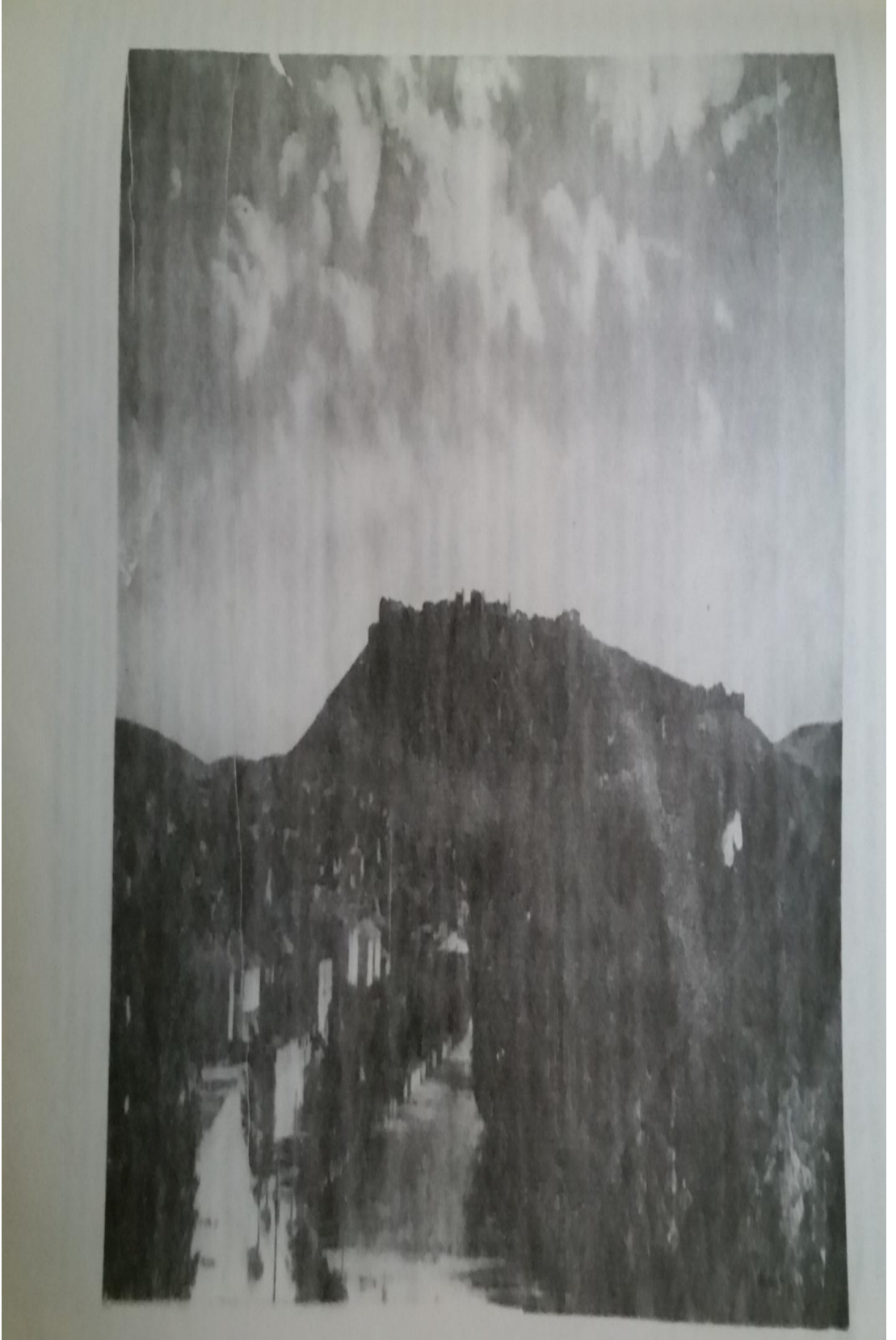
Bayburt Kalesinin Güneyden Görünüşü
