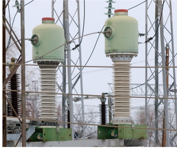
Şekil 3.7. Yağlı tip akım ölçü transformatörü.
