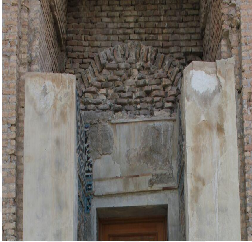
Fotoğraf 3.8. Karabağlar Külliyesi, güney cephe, taçkapı girişi
