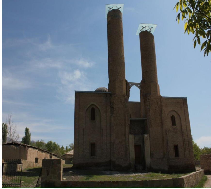
Fotoğraf 3.12. Karabağlar Külliyesi Ön Cephe Görüntüsü
