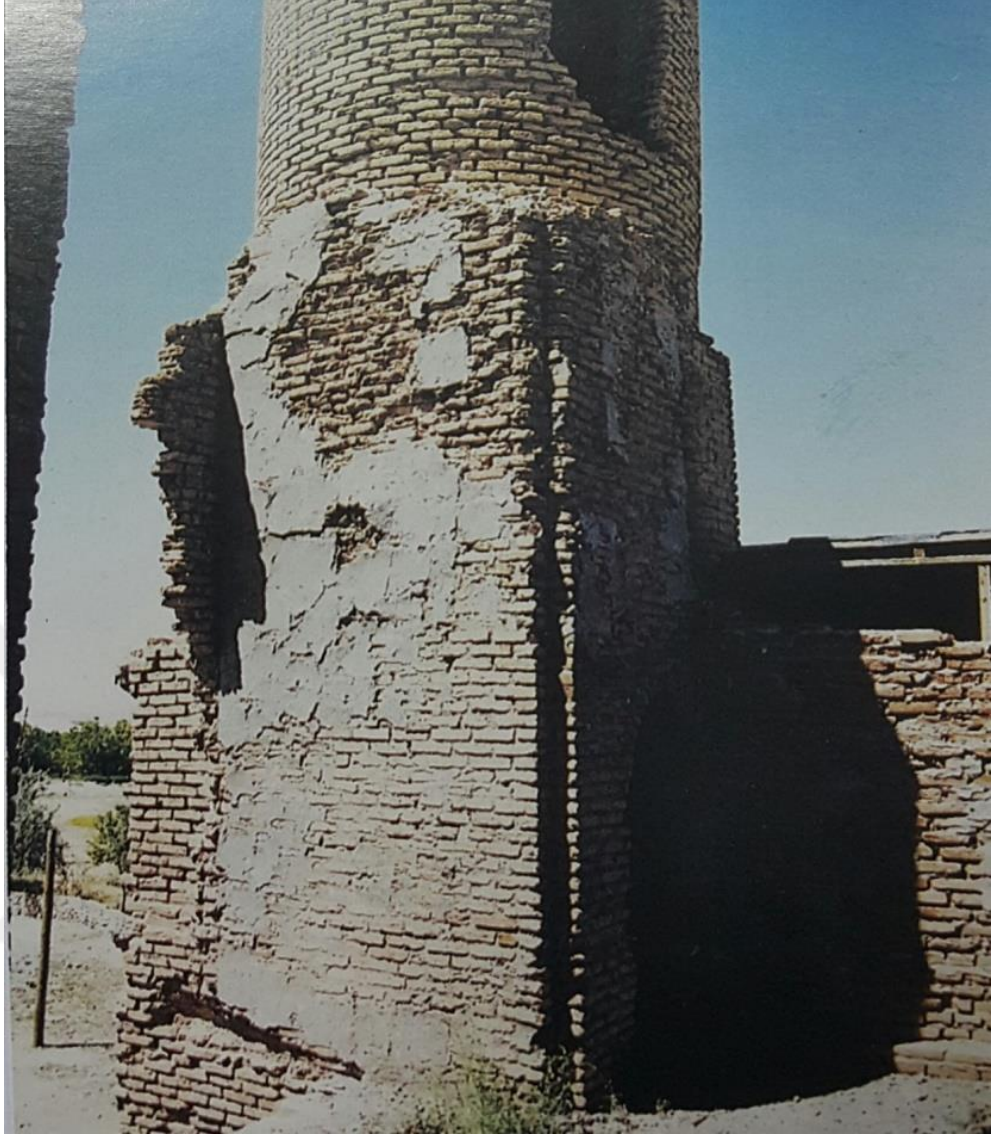
Fotoğraf 3.19. Karabağlar Kümbeti Minare Kaplaması
