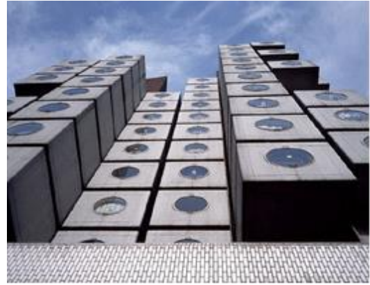
Resim 8. Kapsül Otel dış cephe görünümü. 1972.
