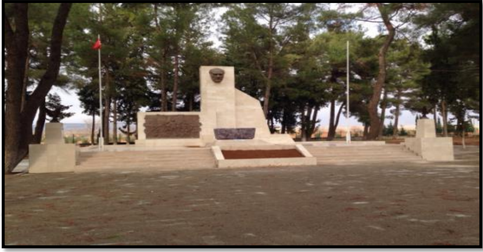
Foto 90. Şahinbey Anıtı-Restorasyon Çalışmaları (2014)
