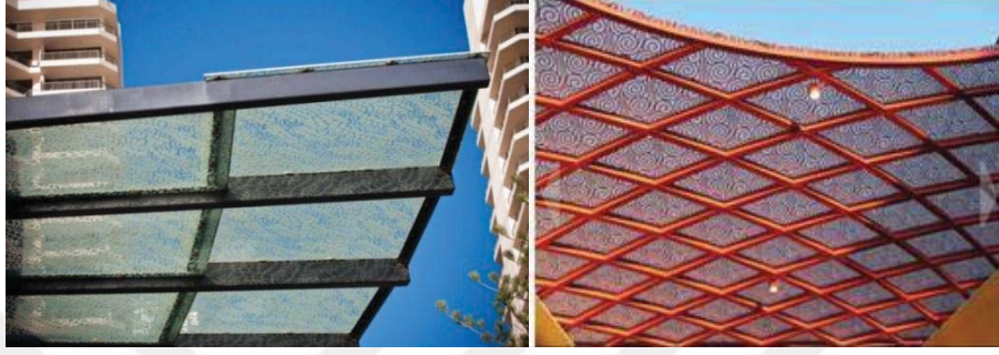
Resim 4.1.14. (a) Cam tavan bina yağmurluk Koruma Paneli Uygulaması. (b) Cam tavan uygulaması, Chinatown Alışveriş Merkezi
