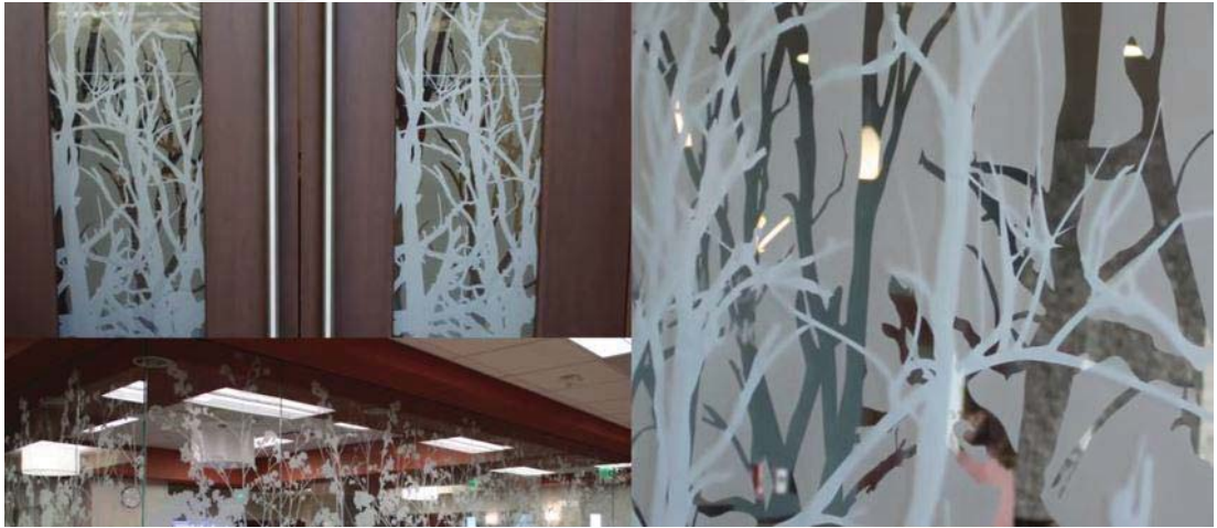
Resim 3.1. Baylor Hastanesi- Teksas, camın ön ve arka yüzüne dijital baskı seperatör uygulaması
