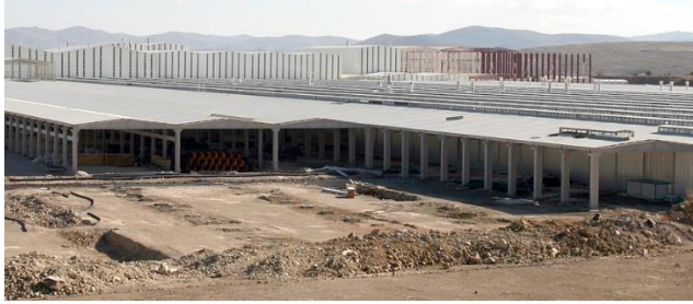
(c) Çankırı granit fabrikası
