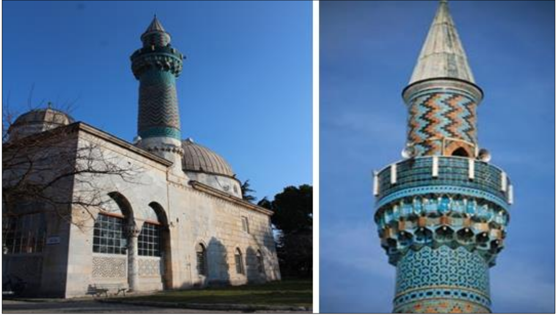
Foto 62 : İznik Yeşil Camii'nden görünüm
