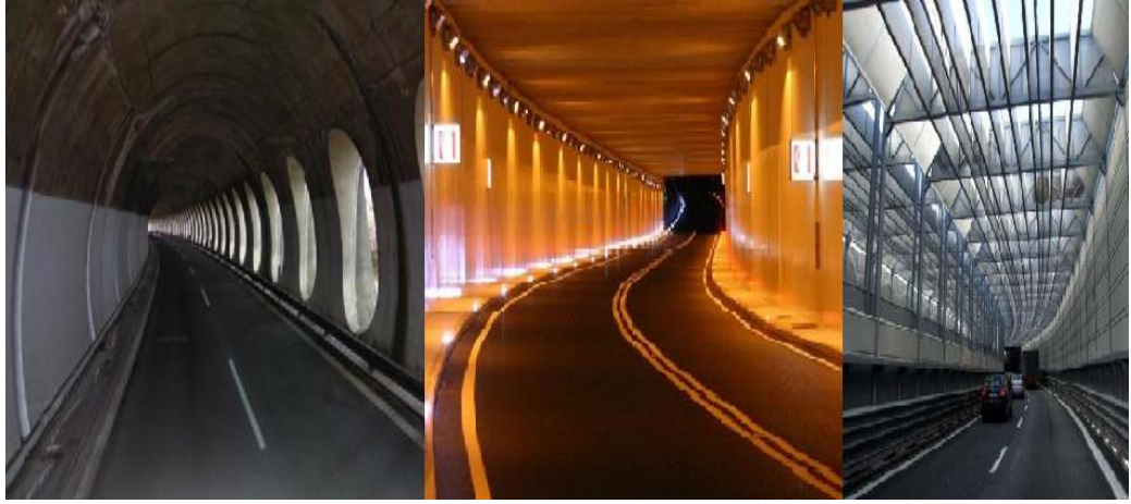
Şekil 3.11. Tünel ve yarı tünellerde flicker etkisi (Dondia, vd., 2012).
