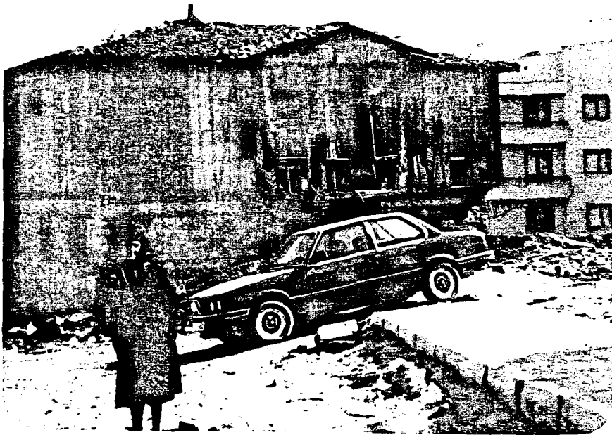
Foto.5: Ankara Evlerinden Gaziosmanpaşa Karlı Sokak'ta yıkılmaya yüz tutmuş bir yapı.
