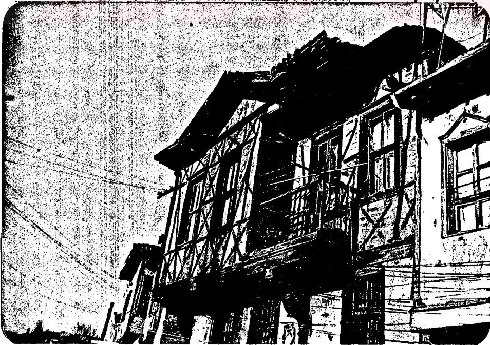
Foto 34: Dutlu Sok.No:10 Göğüslemeli Çıkma
