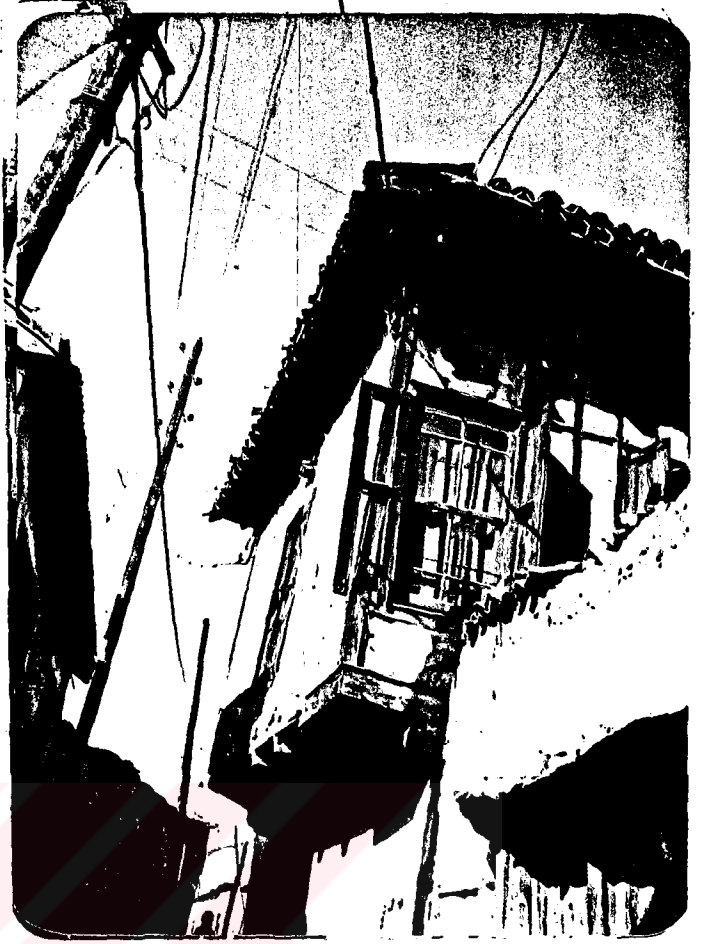
Foto 36: Dutlu Sokak'tan bindirmeli çıkma örneği
