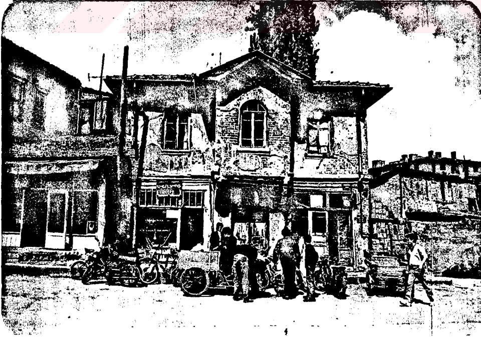
Foto 39: Sarı Kadın Sok.No:71 İlginç cephe görünüşü
