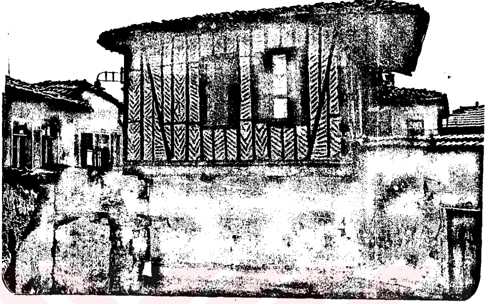
Foto.12: Erzurum Mahallesi ZULUFLU Sokaktan ahşap iskelet yapısına ait bir örnek.
