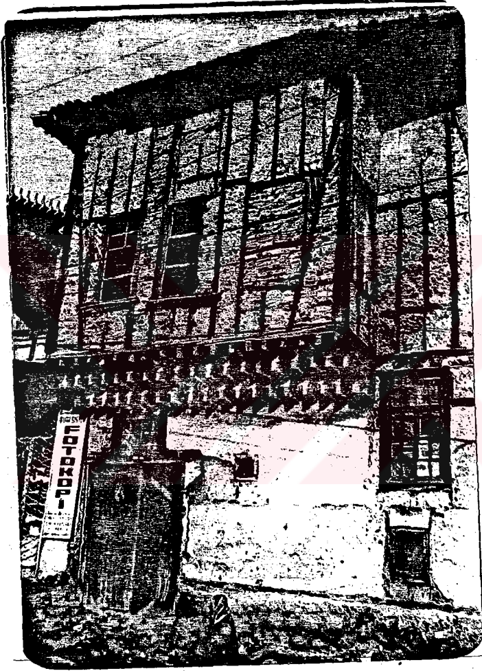
Foto.35: Erzurum Mahallesinde Bindirmeli çıkma.
