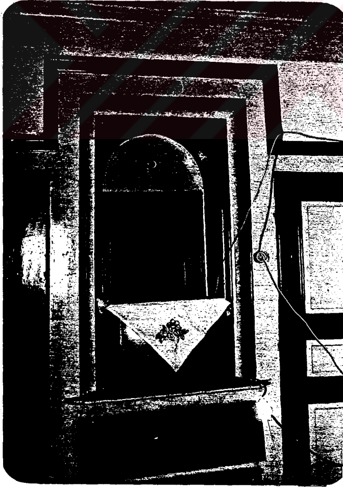
Foto 67: Sarıkadın Sok.No:69 Dolap görünüşü.
