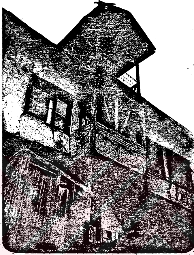
Foto.31: Erzurum Mahallesinde basit bir cıkma görünüşü
