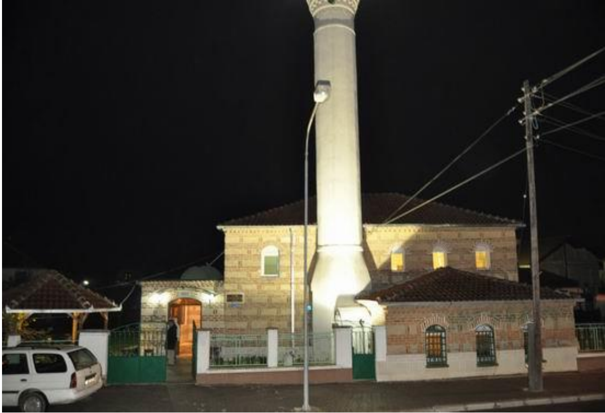
Fotoğraf 2.21. Haydar Paşa Camii'nden bir görünüm
