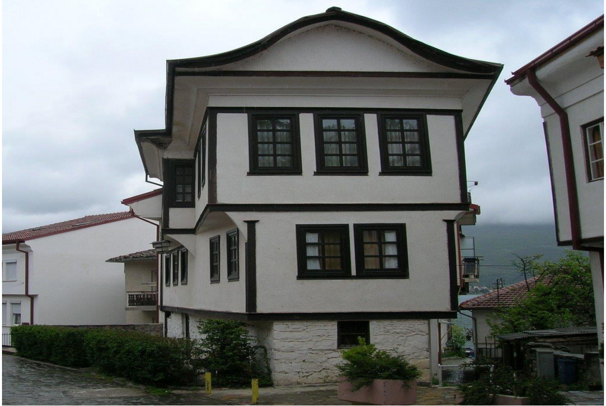
Fotoğraf 2.27. Ohri'de 19. yüzyıla ait Osmanlı sivil mimarisinin izlerini taşıyan bir konuttan görünüm
