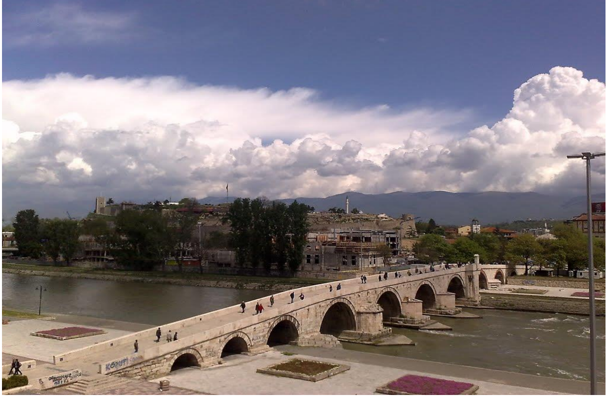
Fotoğraf 1.2. Üsküp'ün simgesi olan Taşköprü'den bir görünüm
