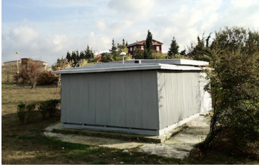
Şekil A.1 : Kandilli Test istasyonu dış görünümü.
