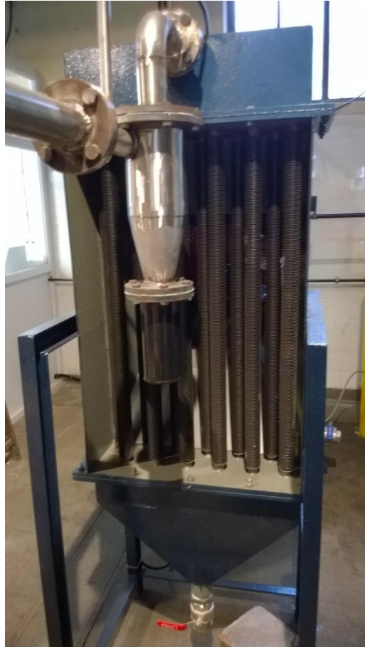
Şekil 3.7: Siklon ve arkasında soğutucunun montaj halinde görünümü.
