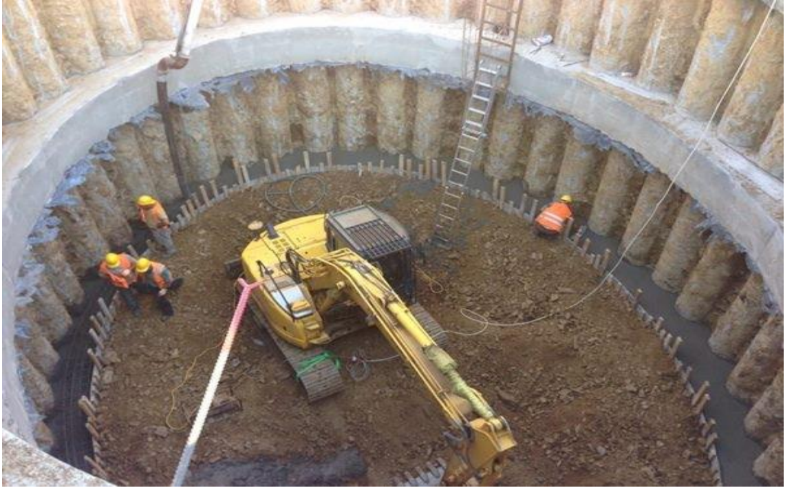
Resim 3.1. Belediye İstasyonu şaft kademe kazısı görünümü
