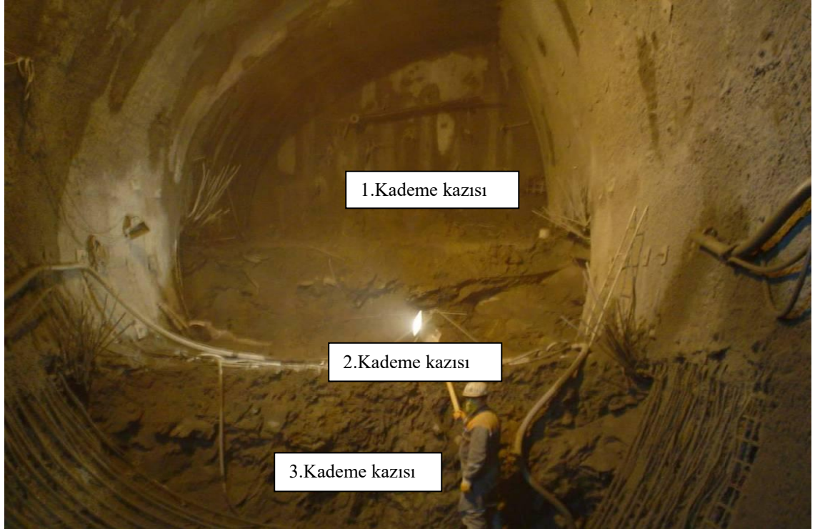
Resim 8.12. Zemin birimlerinde 1,2,3 kademe kazıları
