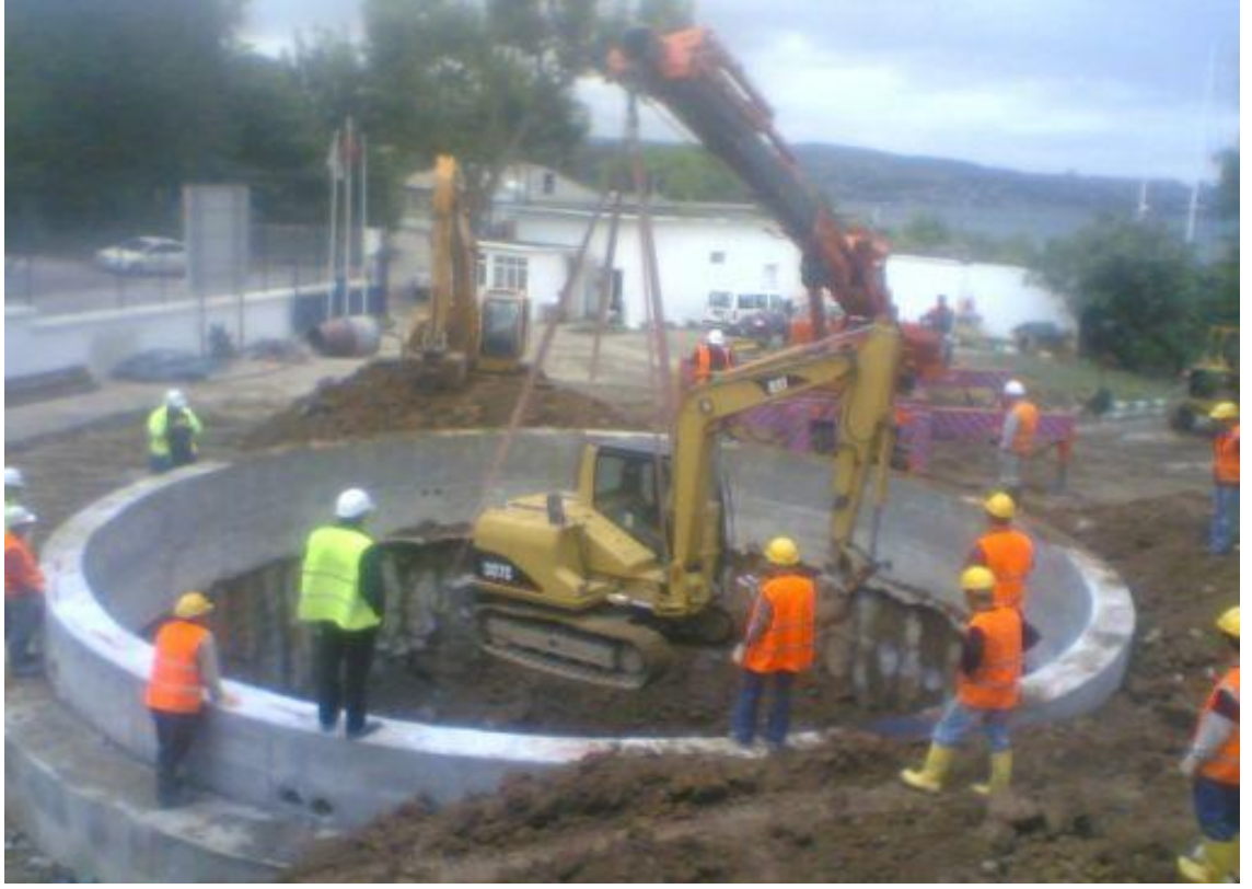
Resim 3.2. Mecidiye İstasyonu şaft kademe kazılarında bir görünüm
