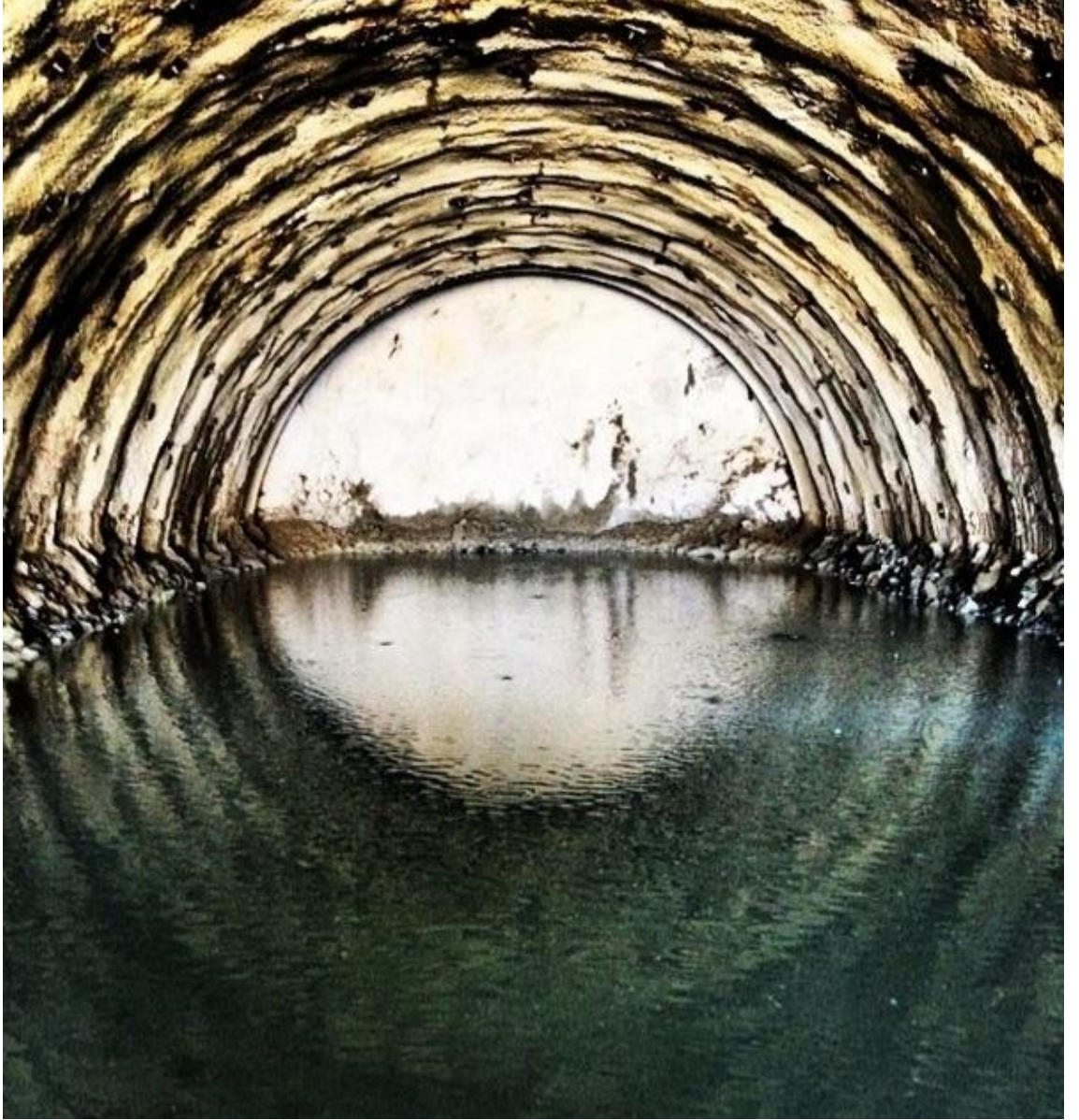
Resim 8.5. B tipi tnel zeminine ait 1. kat elik hasırlı, kafes iksalı ve pskrtme betonlu geilen birim
