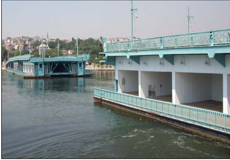
Şekil 5.1: Ramazan etkinliklerinde birleştirilen Eski Galata Köprüsü
