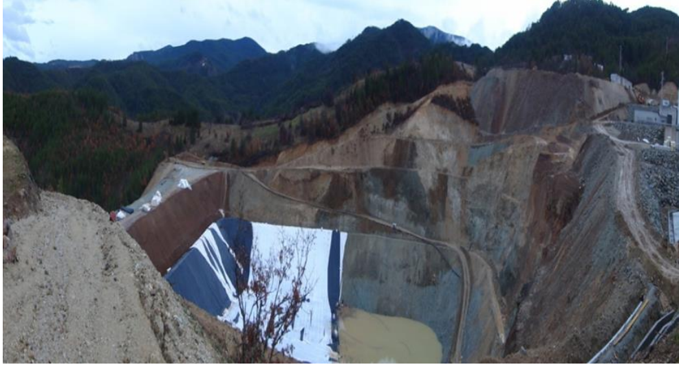
Şekil 2. 7: Aksu Madencilik Dursunbey, Balıkesir Kurşun - Çinko - Bakır İşletmesi artık barajı inşaatı (2012).
