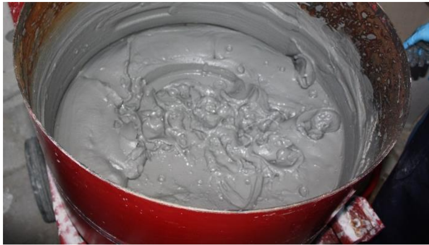
Şekil 3. 8: Beton mikserindeki macun malzeme görünümü.
